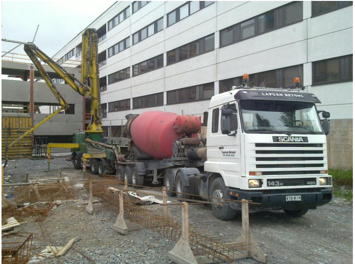
Kuvio 8. Betonin siirto- ja kuljetuskalusto.
