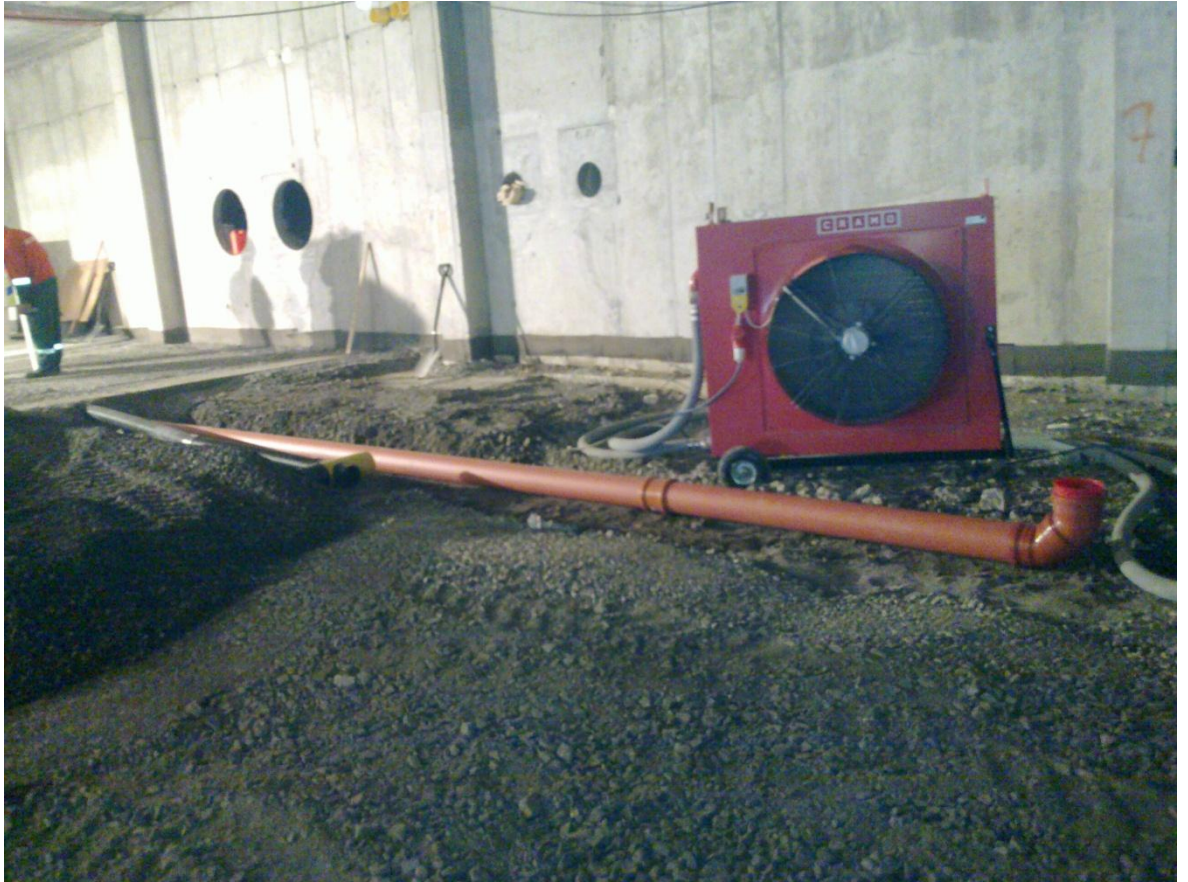
Kuvio 4. Viemäriputken asennus.
