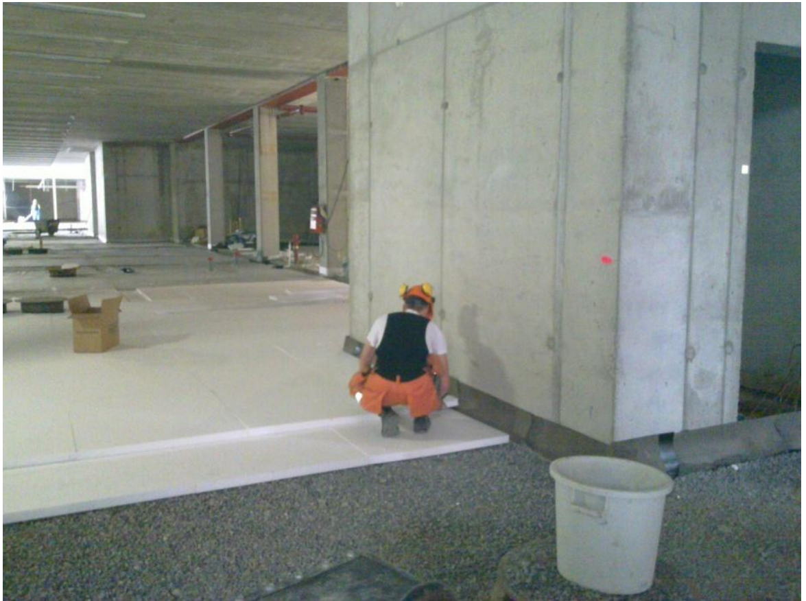
Kuvio 6. Lämmöneristelevyjien asennus.
