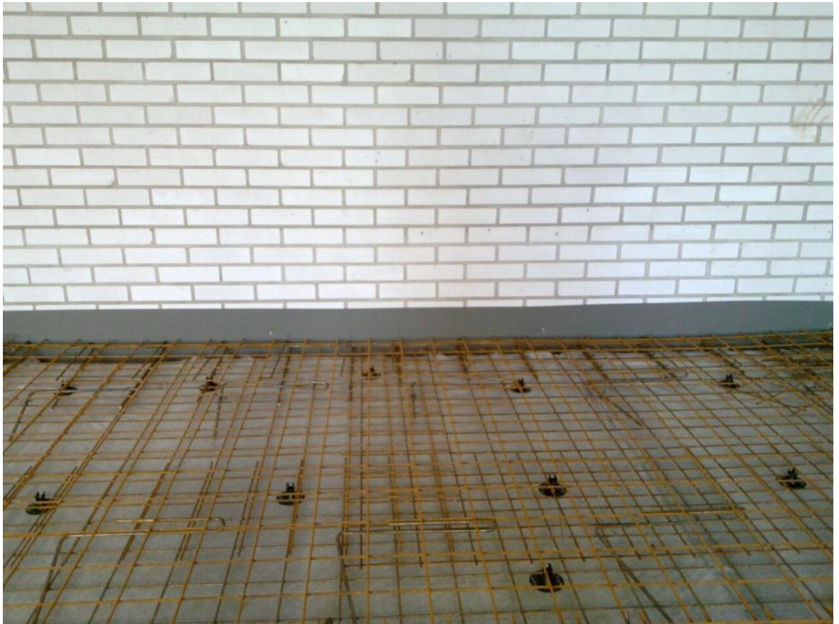
Kuvio 7. Alapohja valmiina raudoitustarkastukseen.
