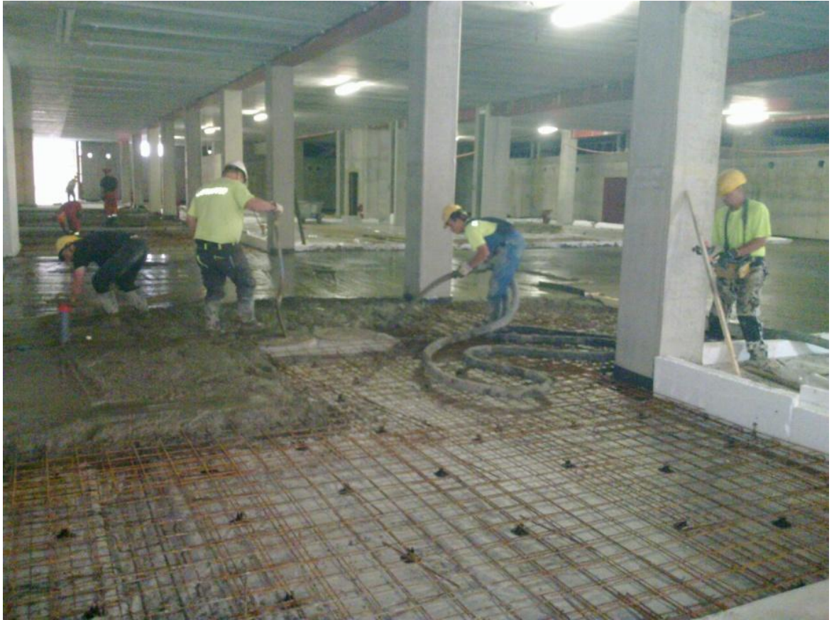
Kuvio 9. Alapohjan betonointi.
