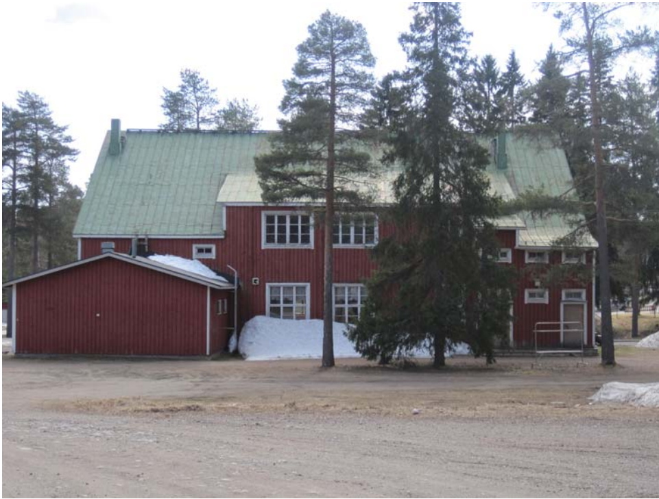
Kuva 1. Paltalinna pohjoinen julkisivu
