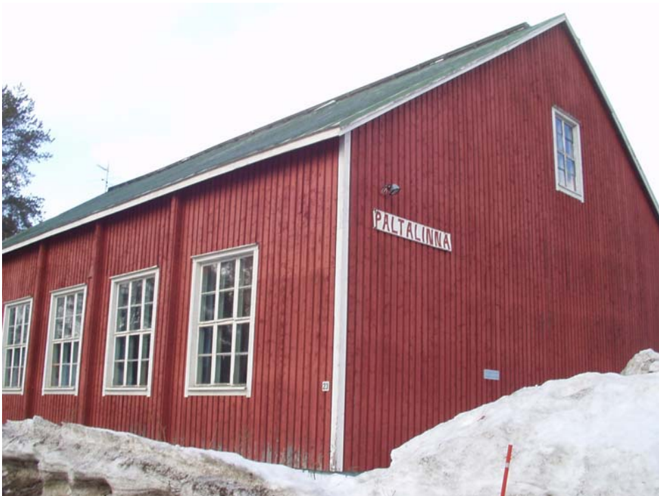
KUVA 2. Paltalinna etelä julkisivu
