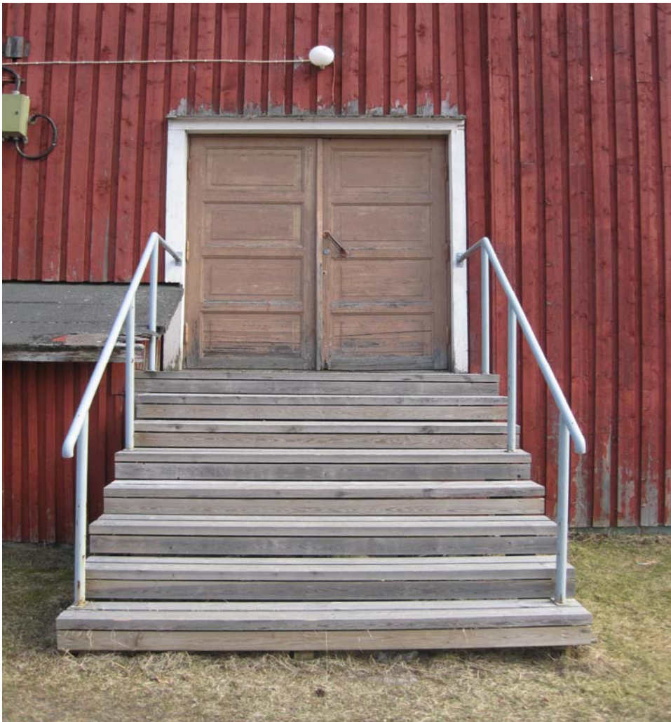
KUVA 9. Paltalinna länsi sisäänkäynti
