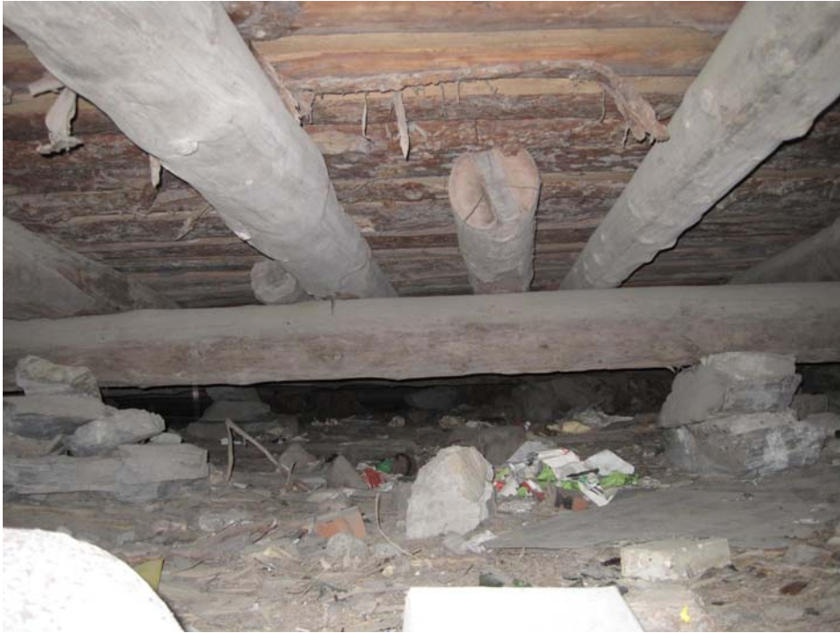
KUVA 14. Paltalinna, alapohjan ryömintätila
