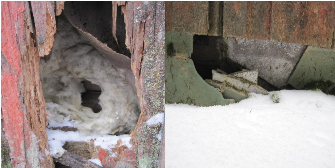
KUVA 6. Pohjoisen sivulla alin hirsikerta on maanpinnan tasolla
