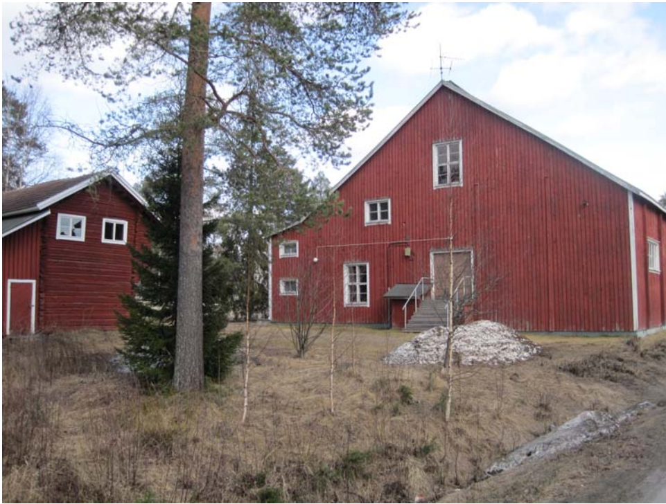
KUVA 5. Paltalinna länsi julkisivu
