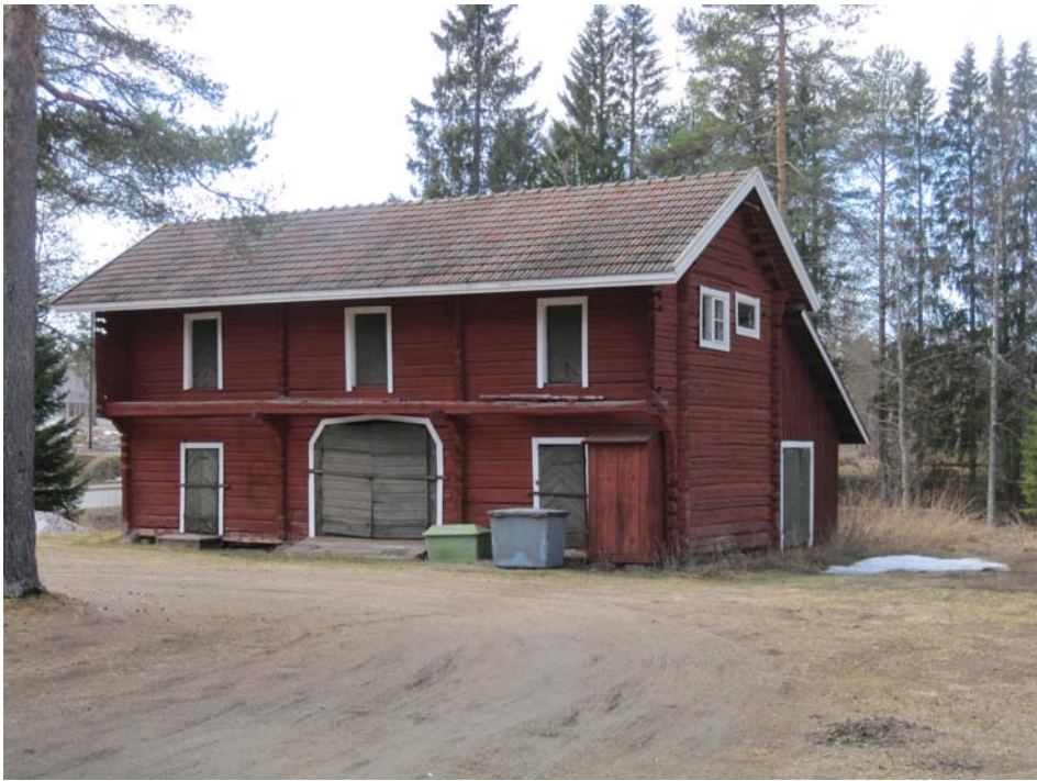
KUVA 12. Tontilla sijaitseva 2-kerroksinen hirsirakenteinen makasiini
