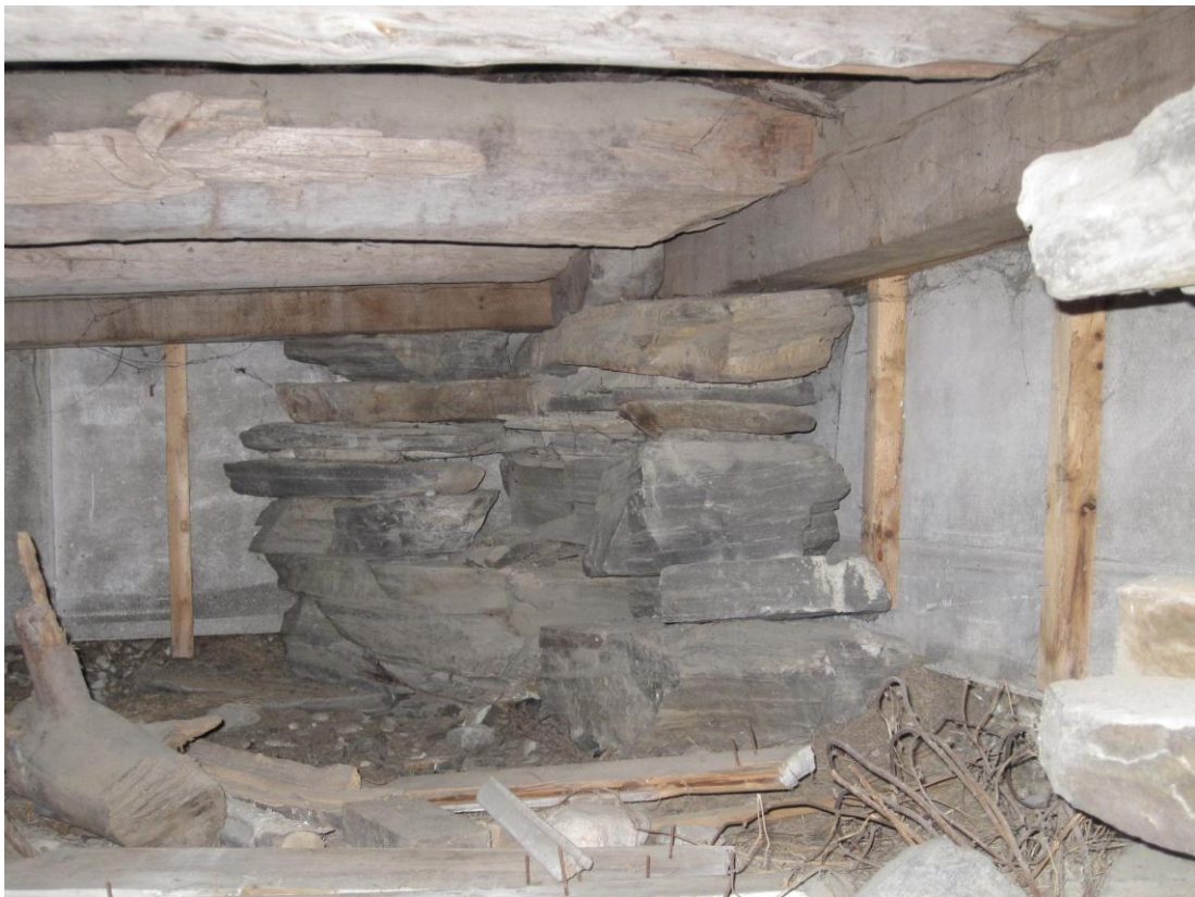
KUVA 3. Perustukset rakennuksen nurkalta
