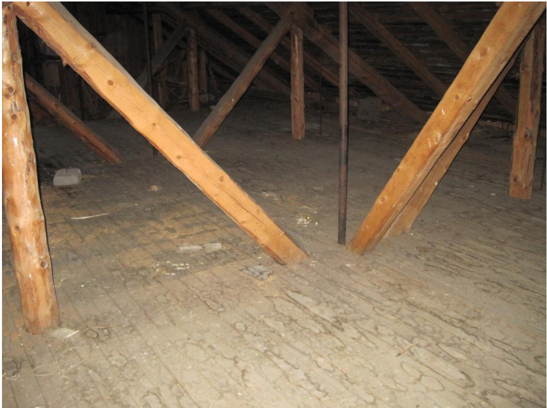
KUVA 7. Yläpohjan päälle asennettu laudoitus
