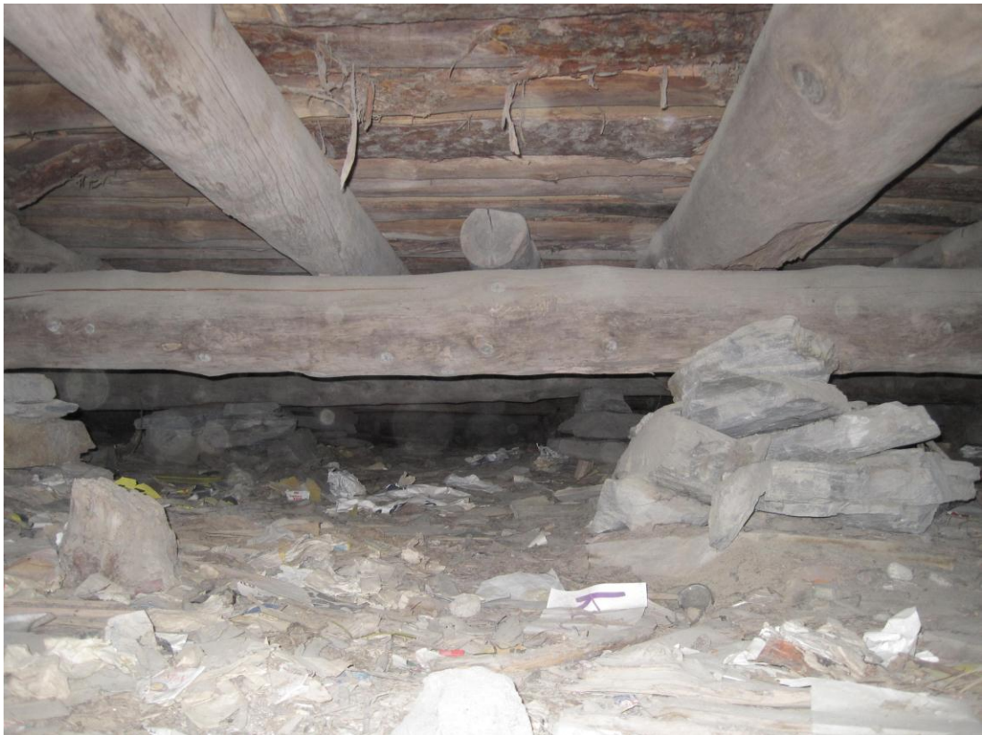
KUVA 4. Alapohja ryömintätilasta salin kohdalta
