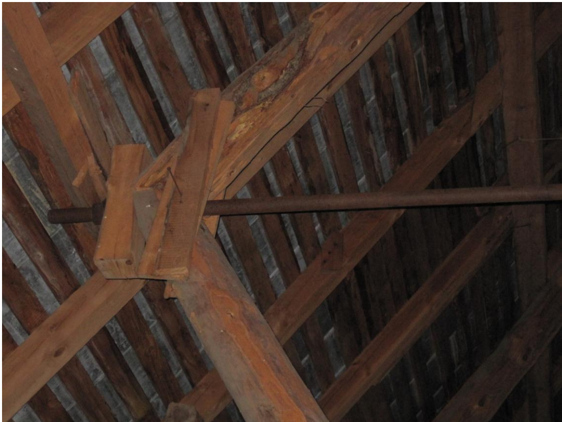
KUVA 5. Yläpohjan jäykistetanko ullakolla
