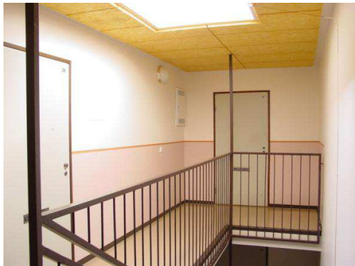
Kuva 35. Nykyinen akustolevyalakatto. Valokuva Jarmo Räsänen.
