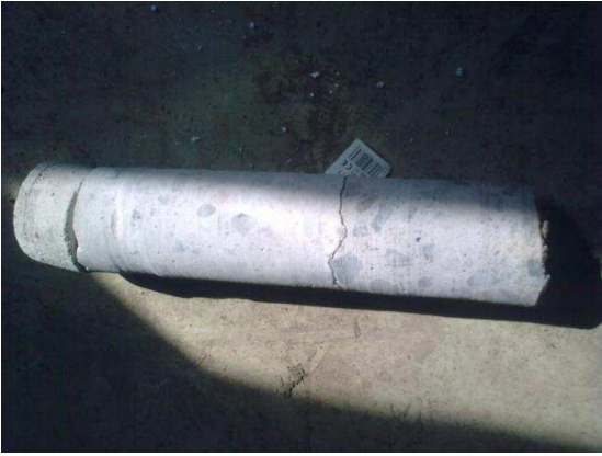
Kuva 23. Porauskappale talon 1 alapohjasta. Valokuva Jarmo Räsänen.
