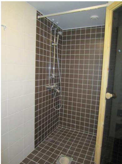
Kuva 30. Valmis kolmion pesuhuone. Valokuva Jarmo Räsänen.
