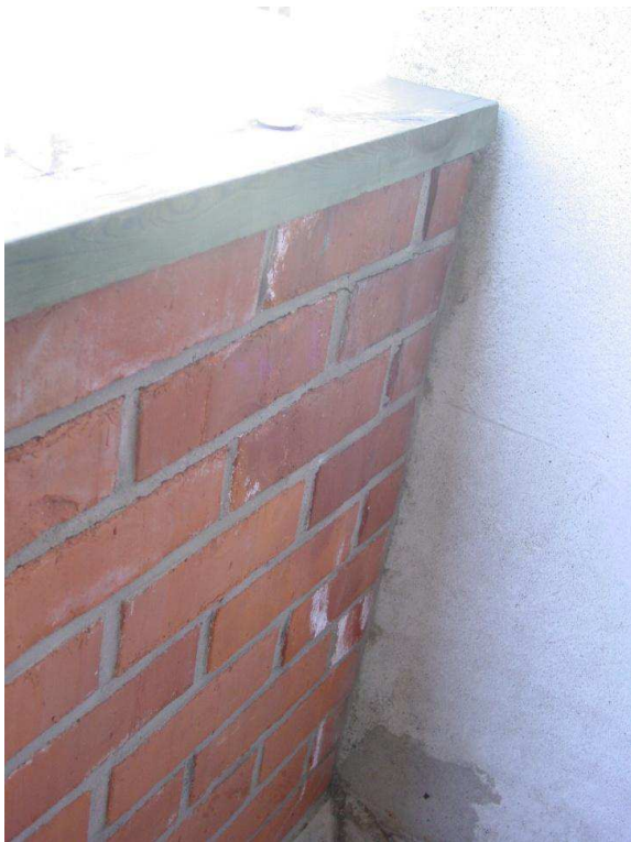
Kuva 42. Nykyinen tiilinen parvekekaide. Valokuva Jarmo Räsänen.
