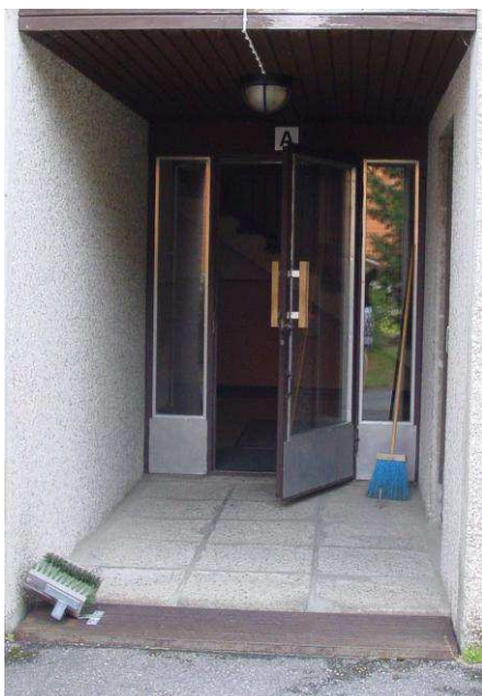
Kuva 45. Sisäänkäynti idästä. Valokuva Jarmo Räsänen.
