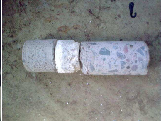
Kuva 24. Porauskappale talon 2 alapohjasta. Valokuva Jarmo Räsänen.
