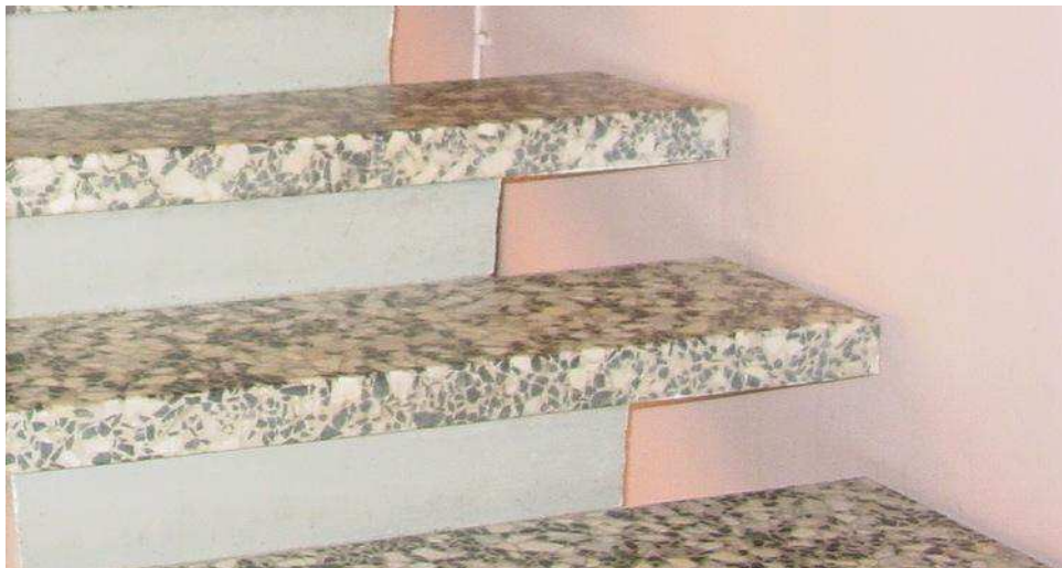
Kuva 48. Porrashuoneen yksivartinen suora portas. Valokuva Jarmo Räsänen.
