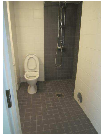
Kuva 31. Valmis kaksion pesuhuone. Valokuva Jarmo Räsänen.
