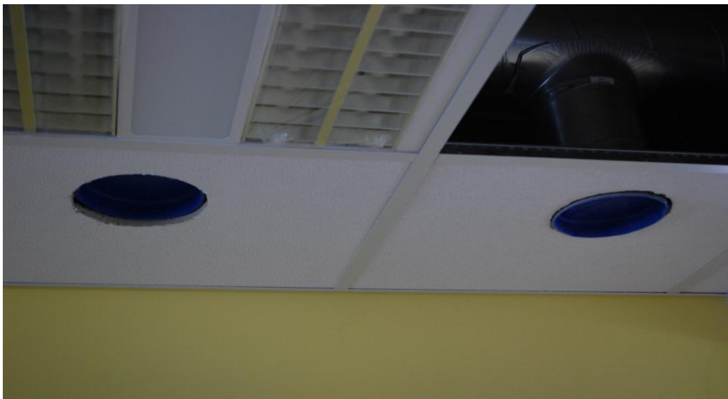
Kuvio 8. Alakaton läpivientien suojauksessa on käytetty putkien kuljetussuojia.
