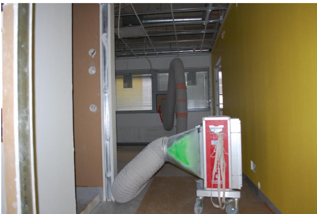
Kuvio 2. Alipaineistamiseen käytettävä laitteisto.
