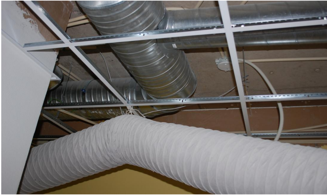
Kuvio 3. Poistoilmaputkien sijoittaminen.
