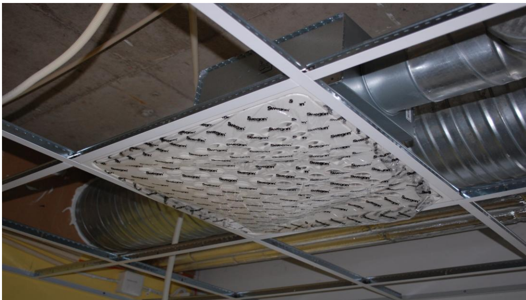
Kuvio 9. Ilmastointilaitteiden suojaus asennuksen jälkeen.
