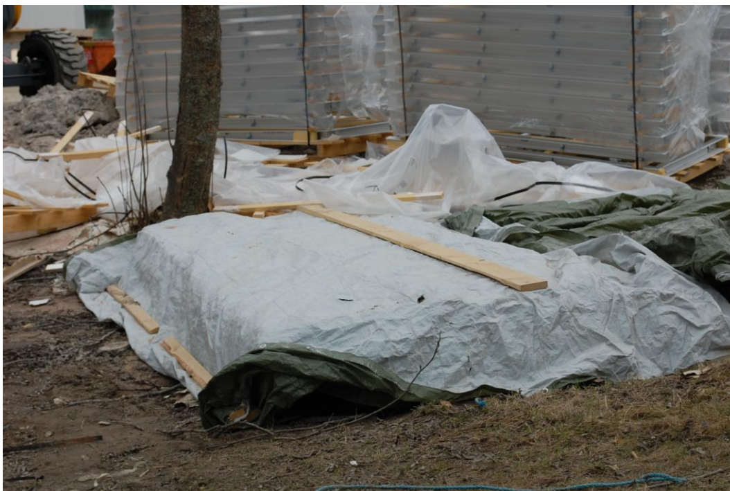
Kuvio 5. Pihalle varastoidut materiaalit on sijoitettu trukkilavojen päälle ja suojattu kevytpeitteen avulla.
