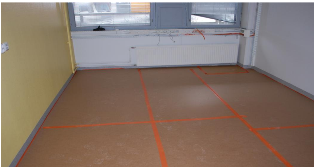
Kuvio 6. Valmiit lattiapinnat suojataan esimerkiksi kovalevyjen avulla.
