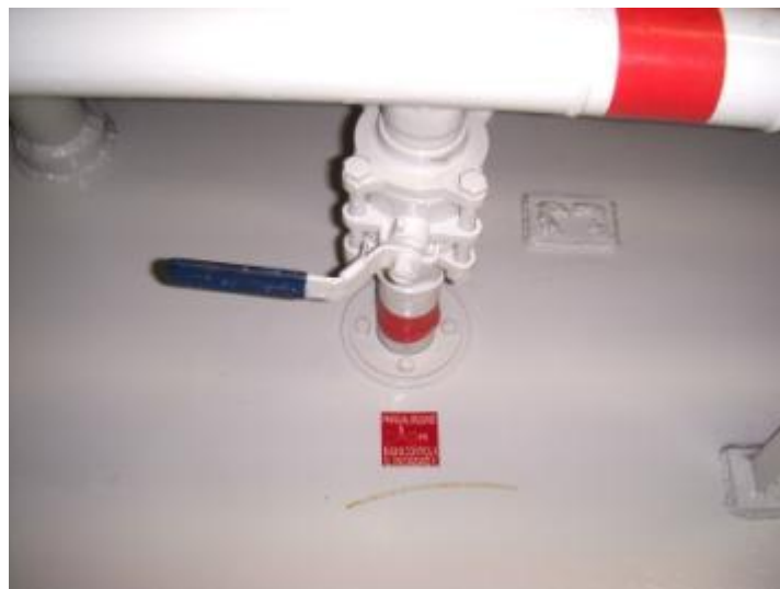
Kuva 26. Konevalvomon ja pääsähkötauluhuoneiden käsiventtiili.
