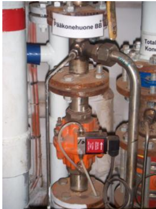
Kuva 29. Local protection-vyöhykeventtiili
