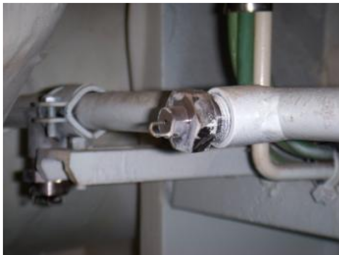
Kuva 12. Konetilojen GW Watermist M2 -mallinen suutin.
