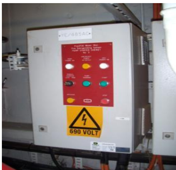
Kuva 16. Pumpun käynnistyskaappi.
