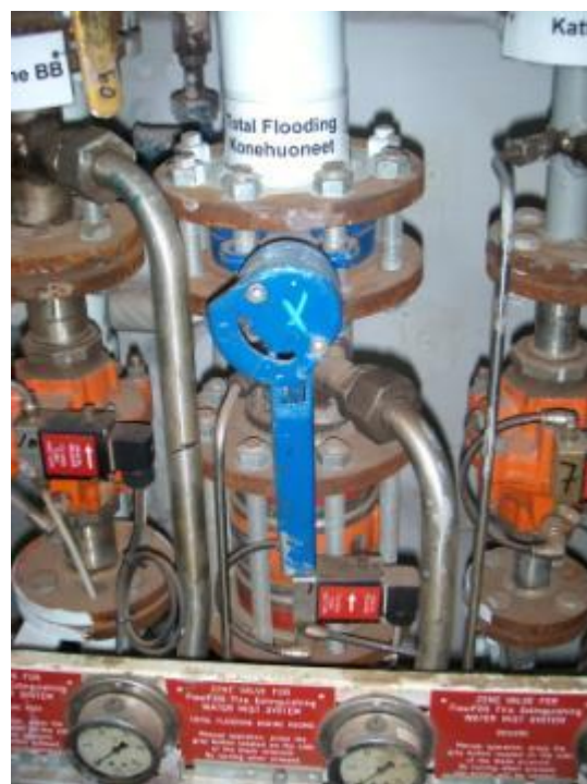
Kuva 31. Total flooding-vyöhykeventtiili
