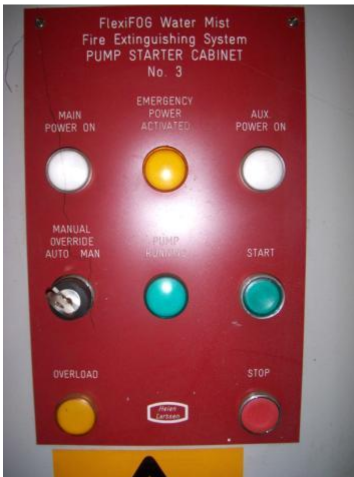
Kuva 38. Pumpun käynnistyskaappi.
