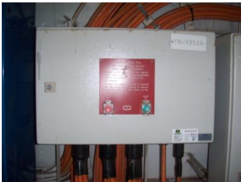
Kuva 6. FlexiFOG-järjestelmän pääohjaustaulu.
