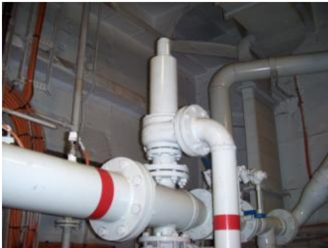
Kuva 15. Painepuolen varoventtiili.
