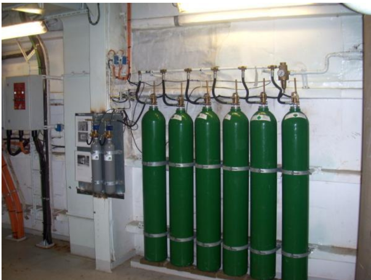
Kuva 31. Typpijärjestelmän typpipullot ja ohjausilmapullot
