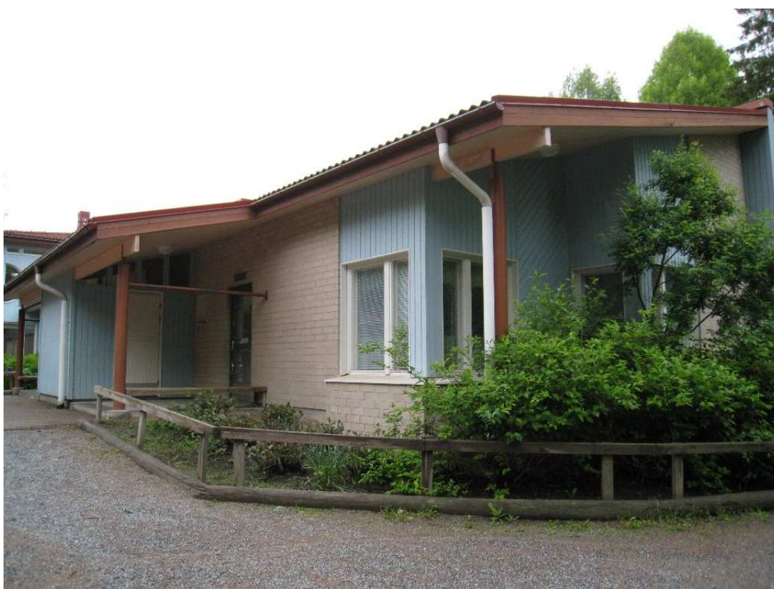
KUVA 10. Päiväkodin I julkisivu
