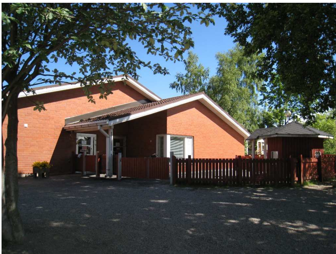
KUVA 3. Päiväkodin C julkisivu
