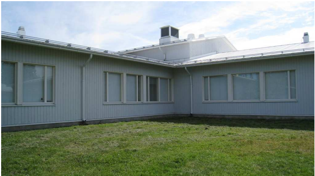
KUVA 8. Päiväkodin G julkisivu
