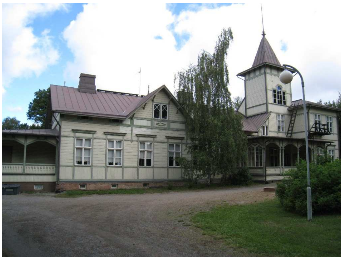
KUVA 11. Päiväkodin J julkisivu
