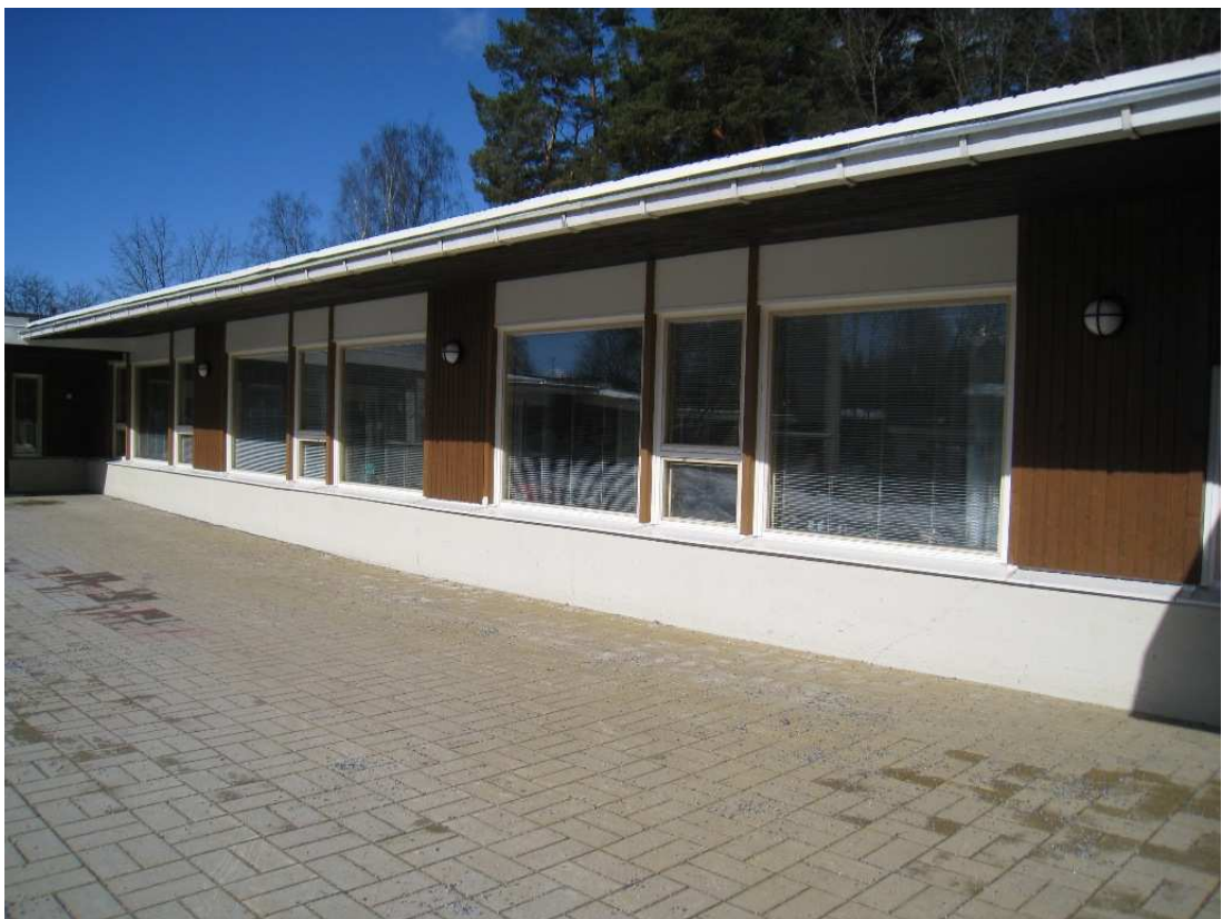
KUVA 4. Päiväkodin D julkisivu
