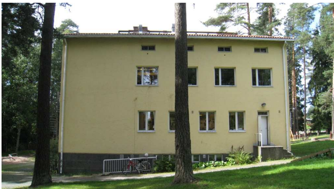
KUVA 9. Päiväkodin H julkisivu
