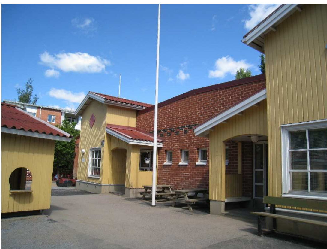
KUVA 1. Päiväkodin A julkisivu
