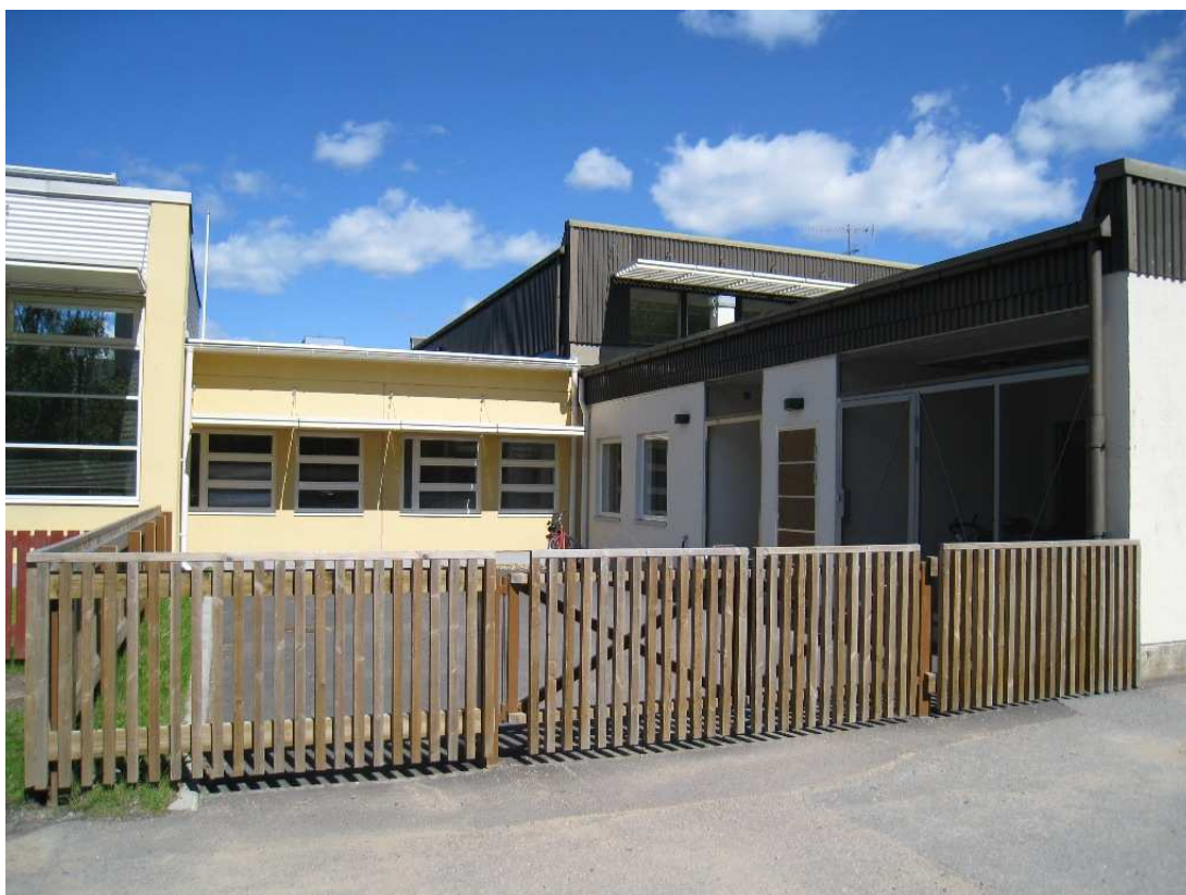
KUVA 2. Päiväkodin B julkisivu
