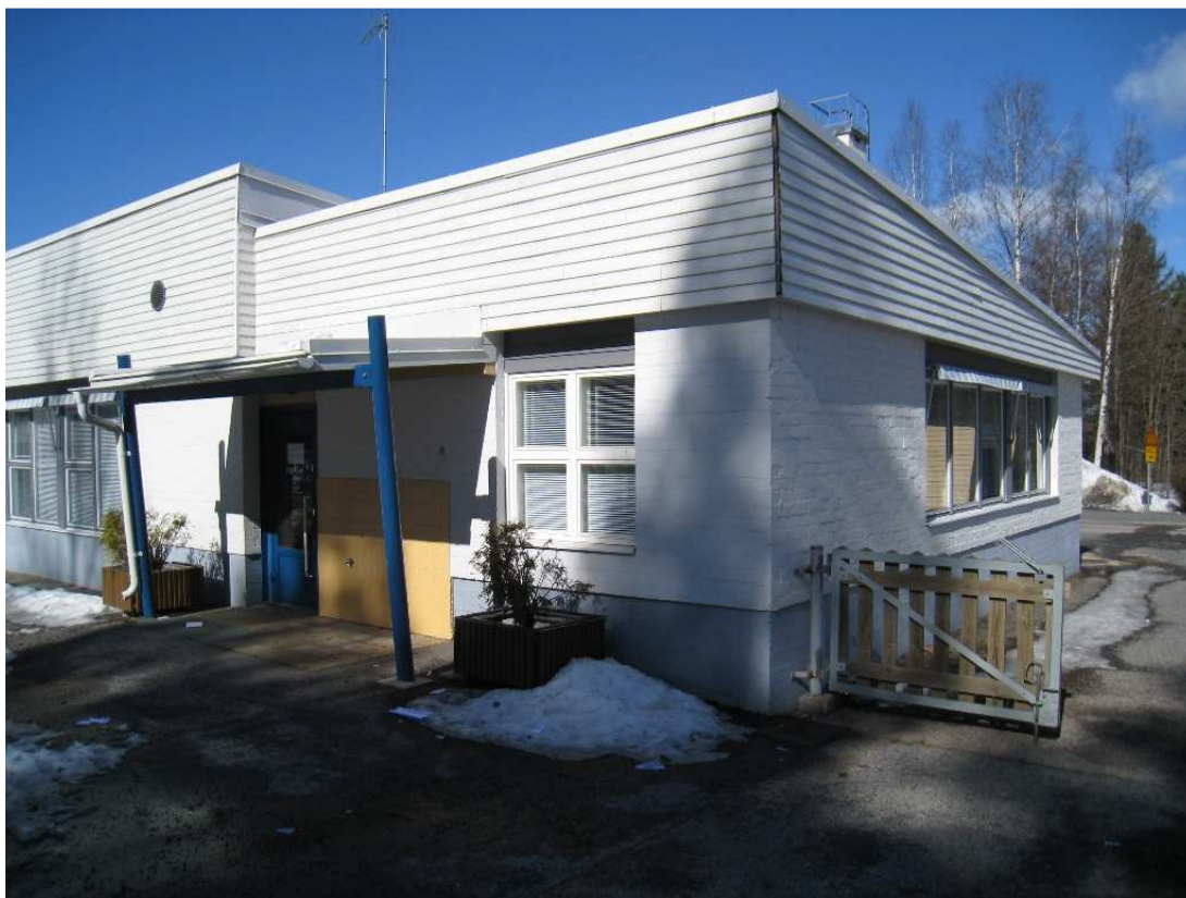
KUVA 5. Päiväkodin E julkisivu
