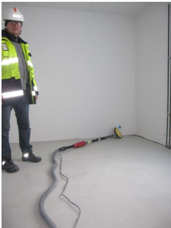
Kuva 17. Hiomalaite- ja kohdeimuri samassa yhteydessä.[14]
