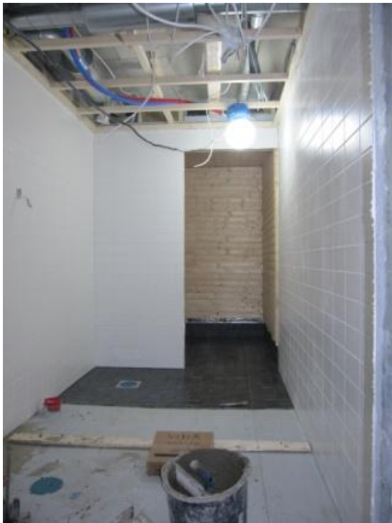
Kuva 14. Saunan- ja pesuhuoneen laatoitus.[14].
