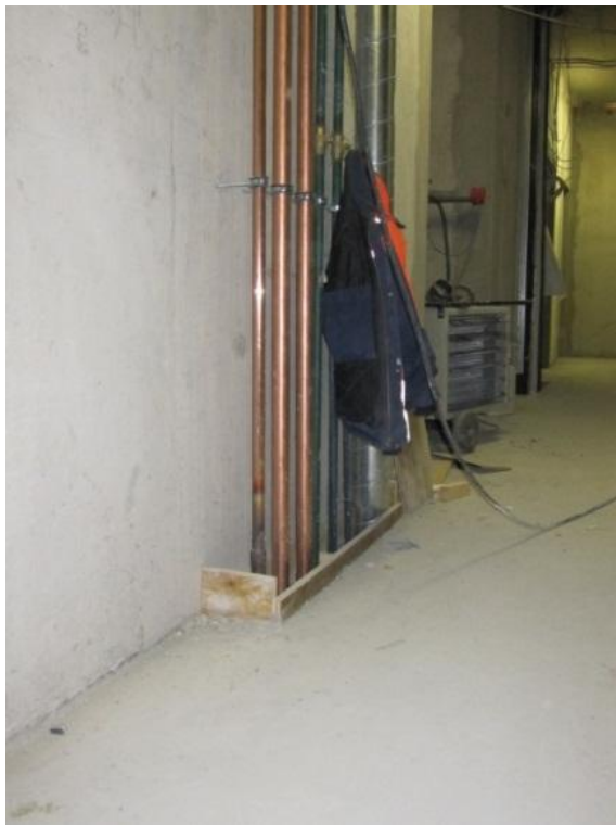
Kuva 9. Läpivientiaukon suojaus.
