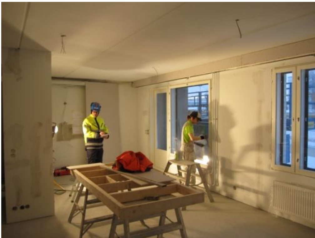
Kuva 8. Työtaso ja maalari maalaamassa.[14].
