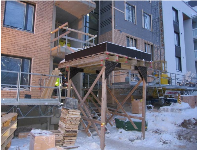
Kuva 5. Oviaukon suojakatos.
