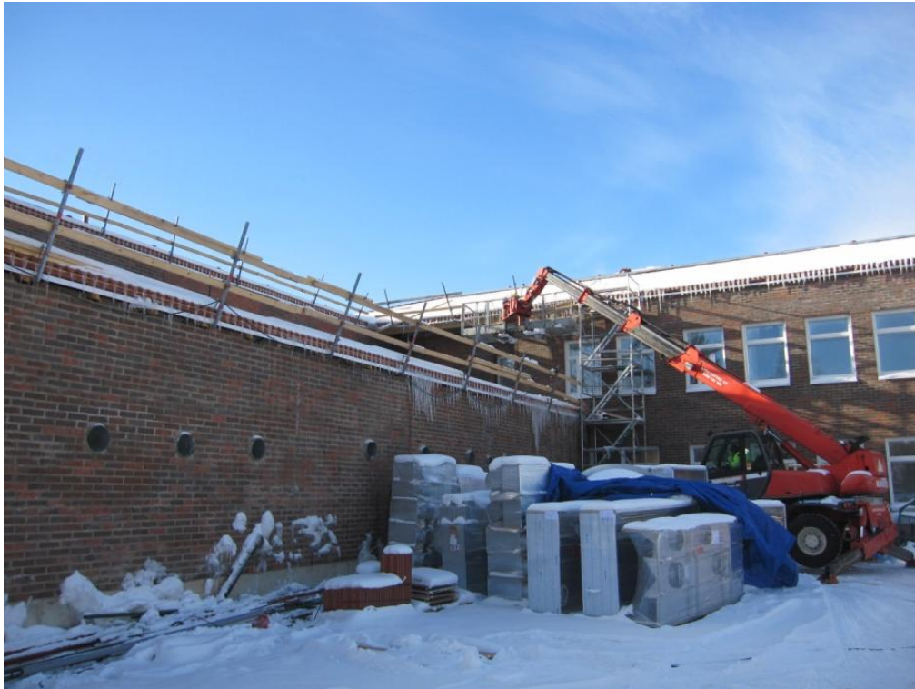
Kuva 8. Putoamissuojausta sekä kurottaja varustettuna henkilönostinkorilla.
