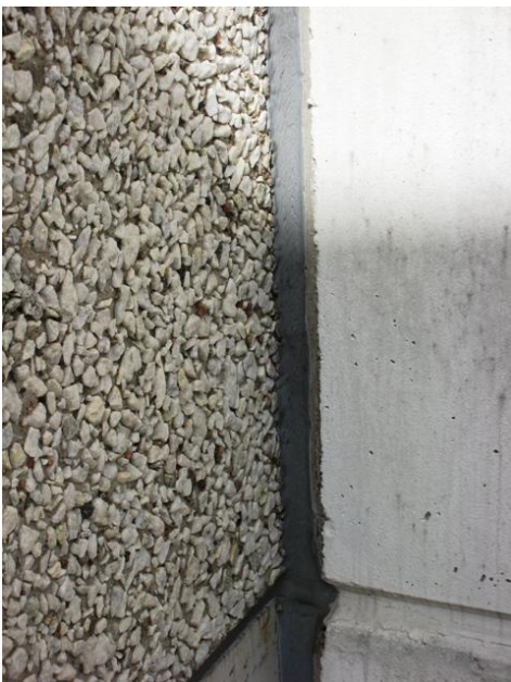
Kuva 9. Ulkoseinän ja piellelementin sauma
