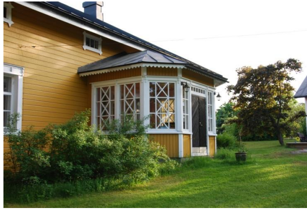
Kuva 11 Katteluksen tilan päärakennus
