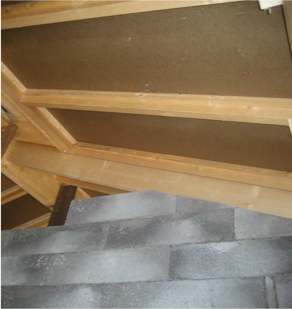
Bild 4 Ett halvfärdigt tak och en murad mellanvägg på en bastubyggnad
