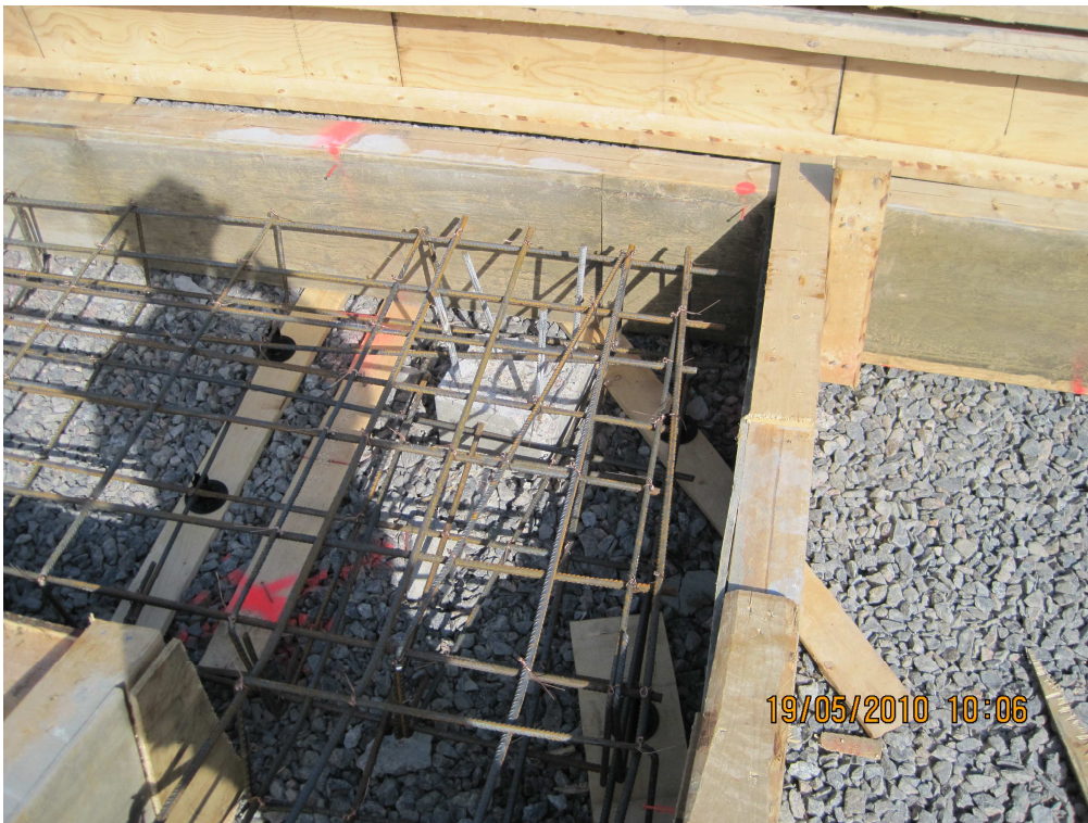
Bild 7 Ett färdigt armerat hörn på plint, observera betongpålen.
