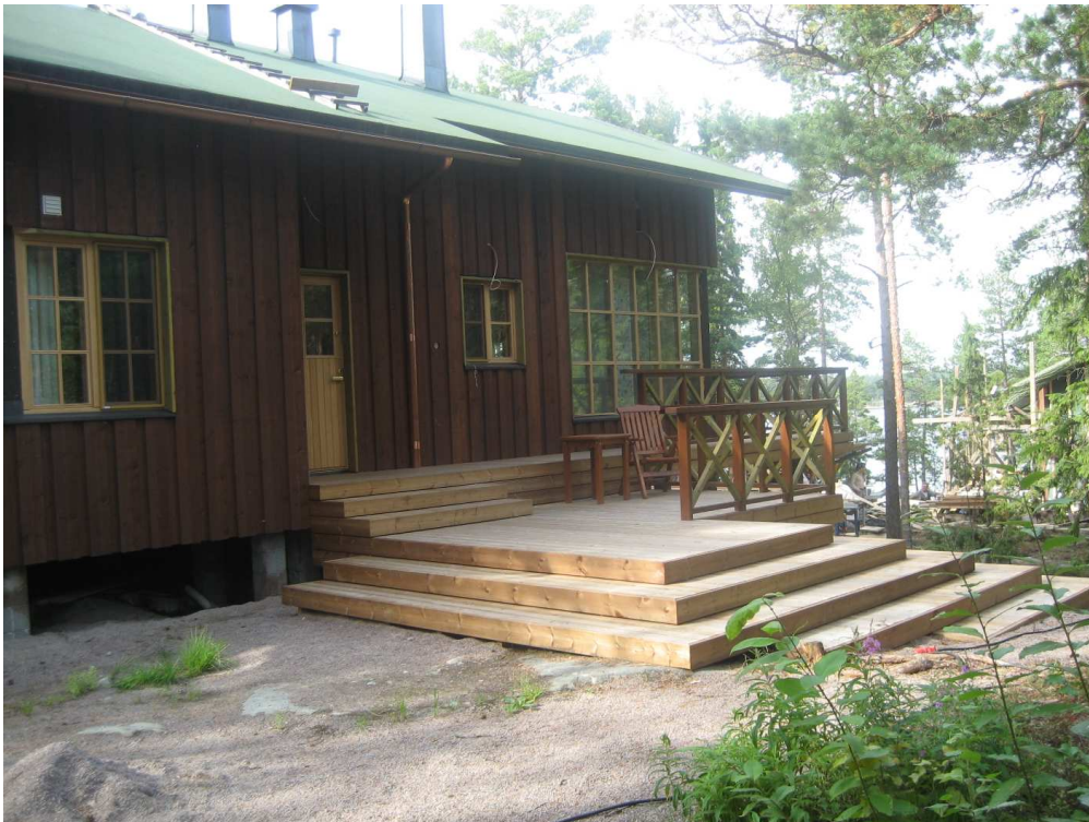
Bild 6 Sommarstuga färdig för slutgranskning
