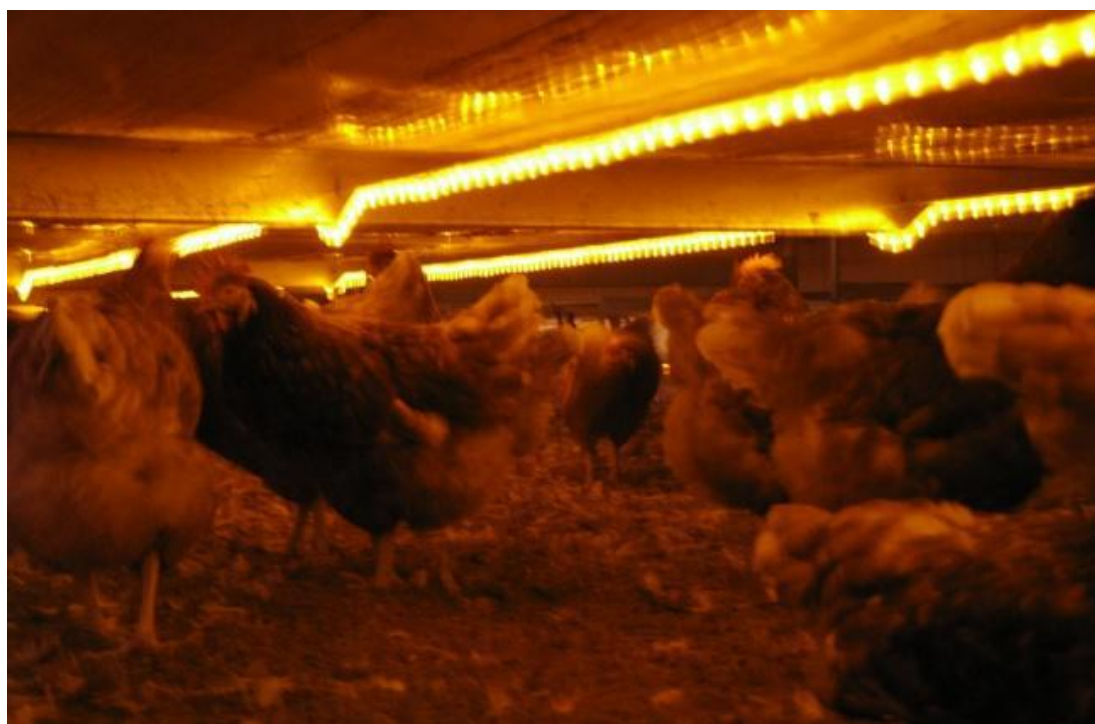
Kuva 9. Led-köysi häkkien sisään asennettuna.
