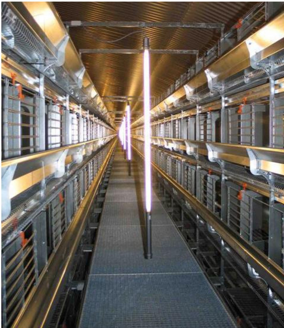
Kuva 5. Loisteputkivalaistus virikehäkeissä 2012 jälkeen (Obers 2009, 20)
