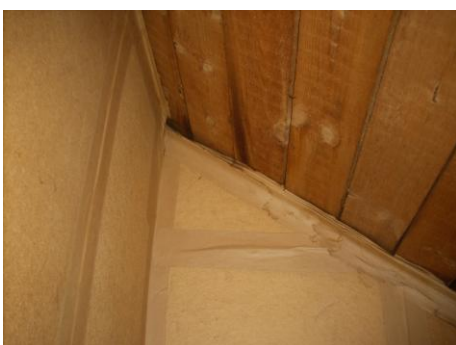
Yläpohjarakenteet ovat säilyneet moitteettomassa kunnossa
