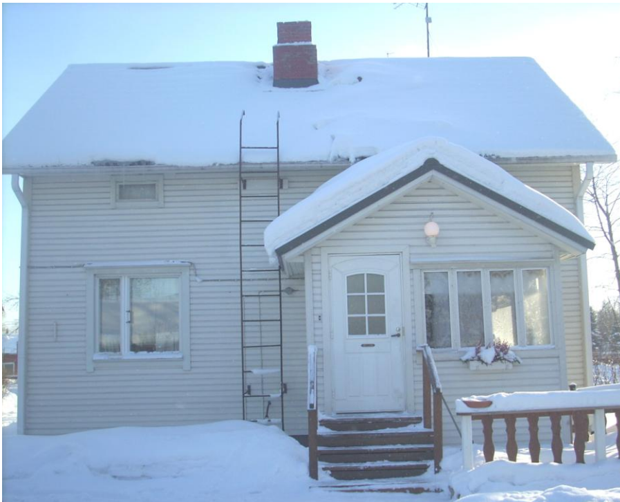
KUVA 2. Kiinteistön pihanpuoleinen julkisivu.
