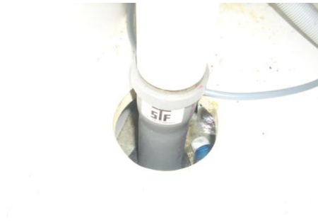
KUVA 16. Allaskaapista puuttuu vesieristys.
