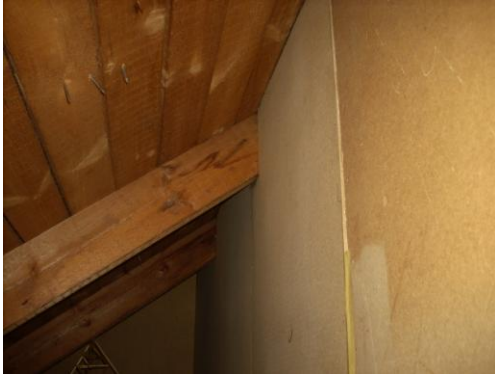
KUVA 10. Yläpohjarakenne on tyydyttävässä kunnossa.
