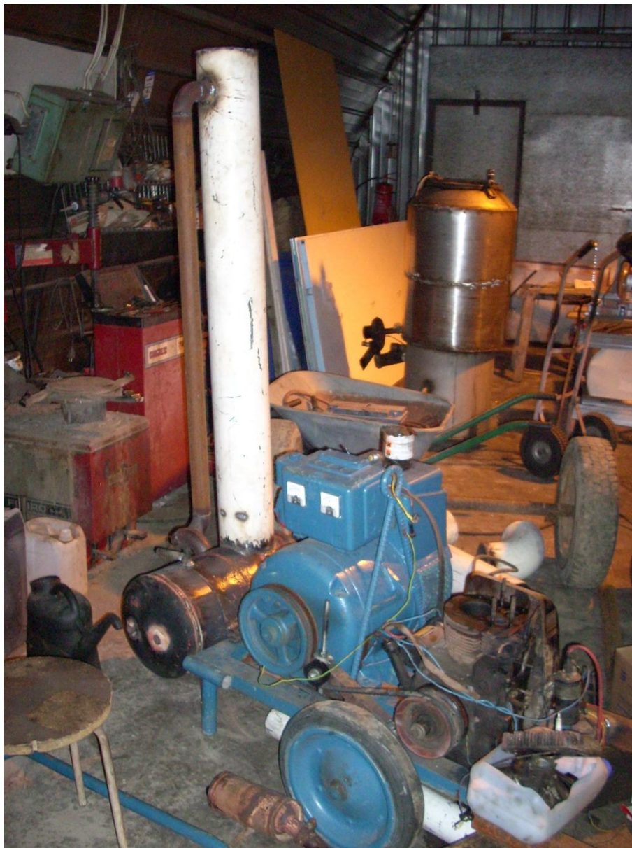
Figur 6 Skrubber, Generator med uttag volt- och ampere- mätare, samt motorn. (Egna bilder)
