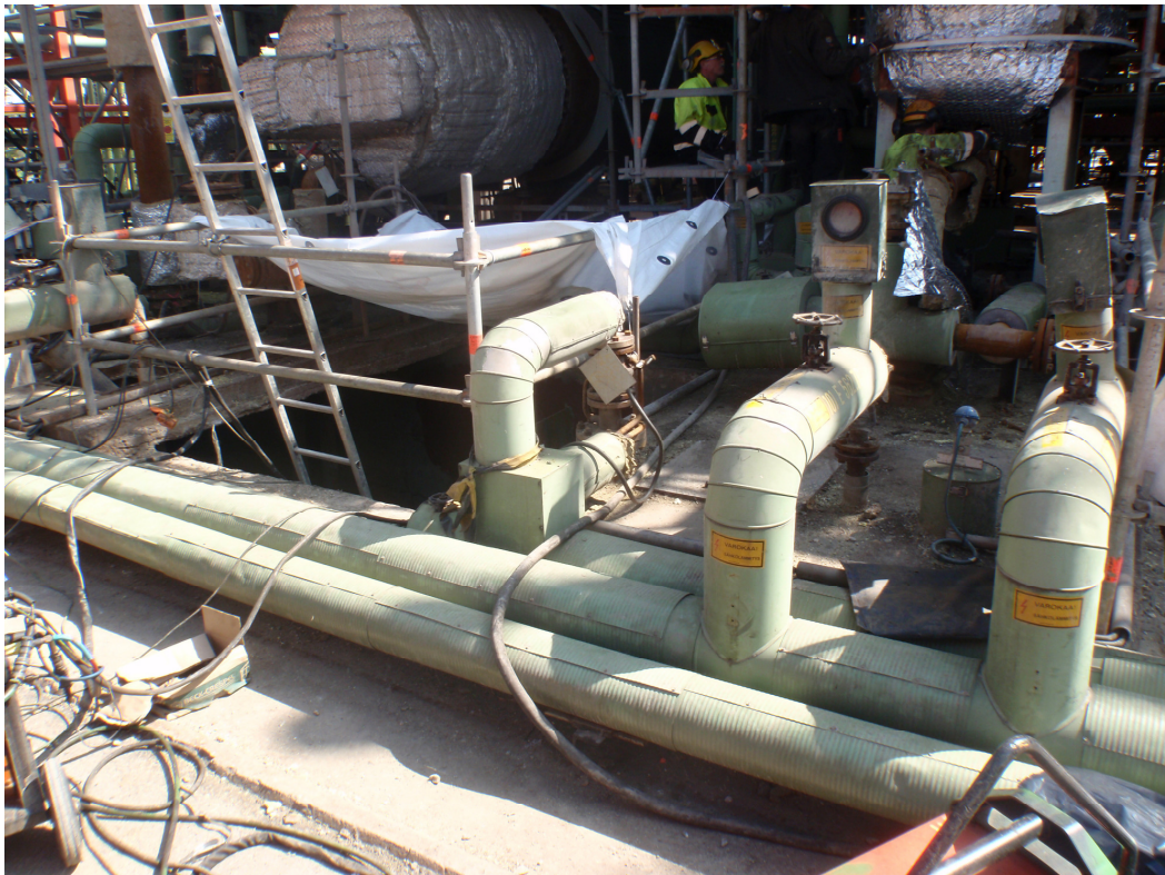
Kuvat 2 ja 3. Punaiset kohdat ovat Epoksi-pohjaisella pinnoitteella käsitellyjä kohtia joissa oli rapautumisvaurioita. (T.Mikkeli 2010)
