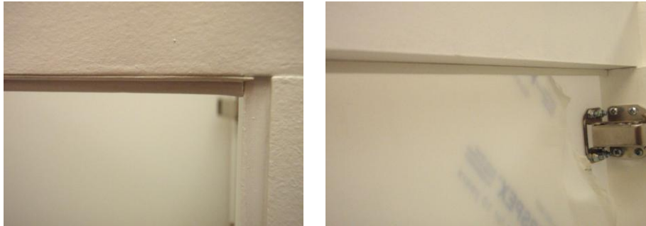
Kuva 48 Luukun ja kehikon väliin tuli tiivisteet.
