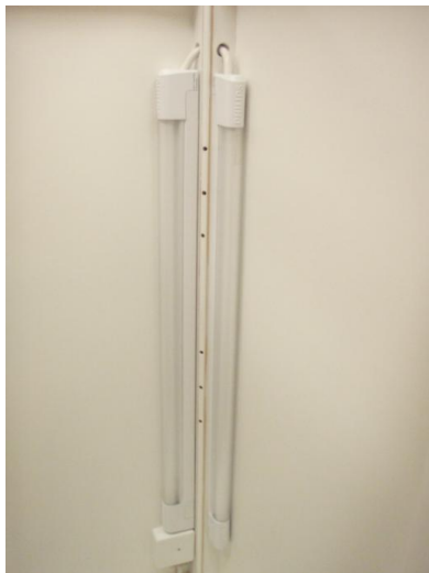
Kuva 62 Loisteputkivalaisimet kiinnitettyinä paikoilleen.
