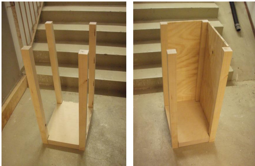
Kuva 27 Pohjalevy, tukipylväät ja seinälevyt
