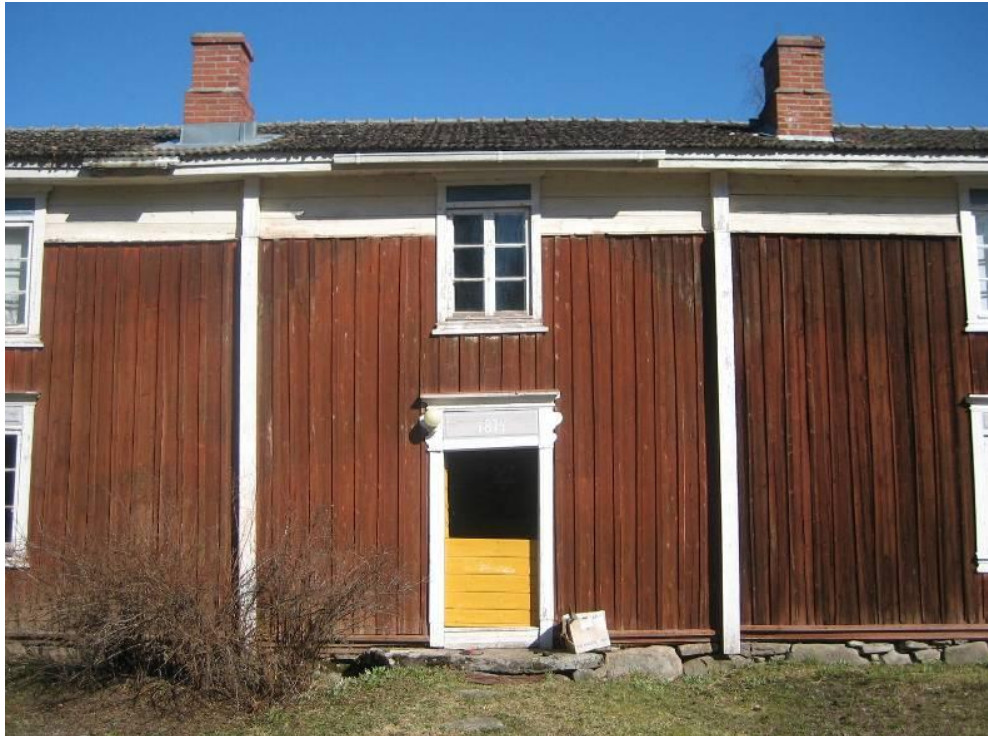
Kuva 11. Kuistin hahmo rakennusrungon seinäpinnassa.
