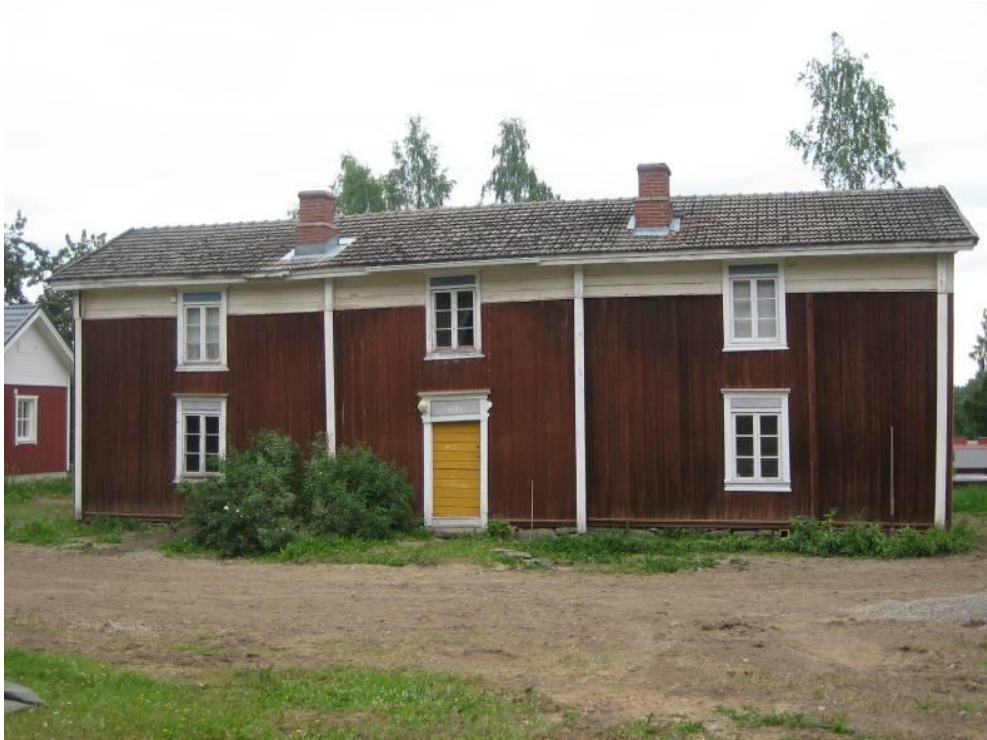
Kuva 10. Haapalan talo nykyisin, julkisivu länteen.
