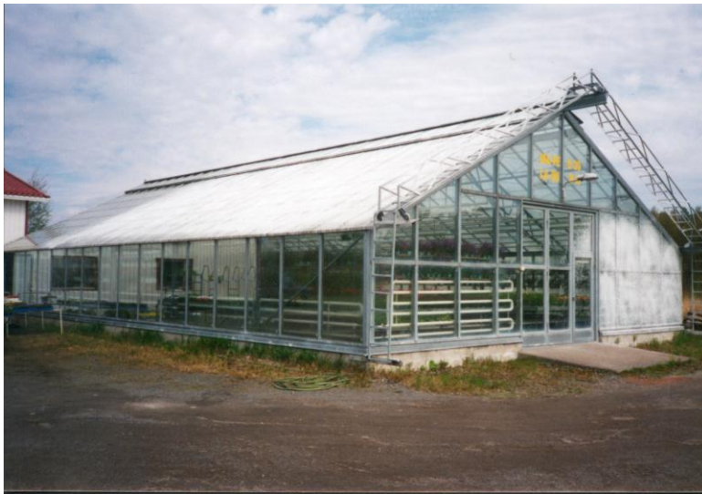
Kuva 1. Kasvihuone (Porin laatuteräs Oy 2003).
