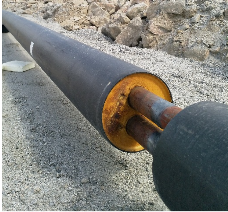
KUVA 2. Kiinnivaahdotettuja kaksiputkielementtejä (Heikkinen 2019-07-02)
