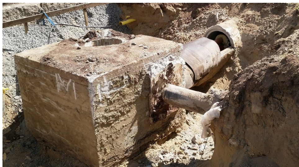
KUVA 5. Betonikaivo ja vanha betonikanavajohto on kaivettu esille työmaalla (Heikkinen 2019-07-26).
