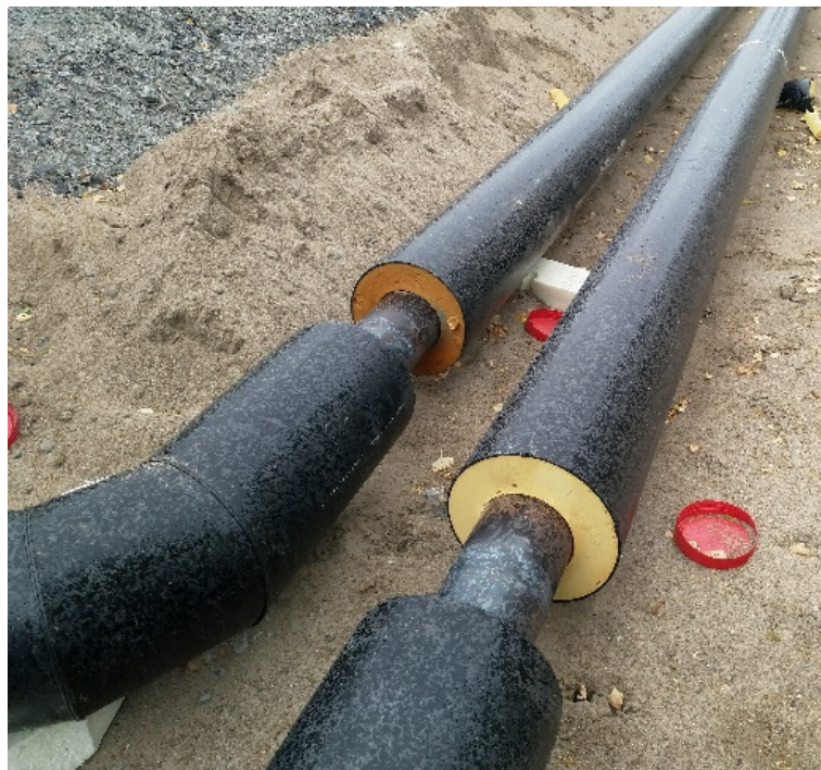
KUVA 1. Kiinnivaahdotettuja yksiputkielementtejä (Heikkinen 2019-07-30)
