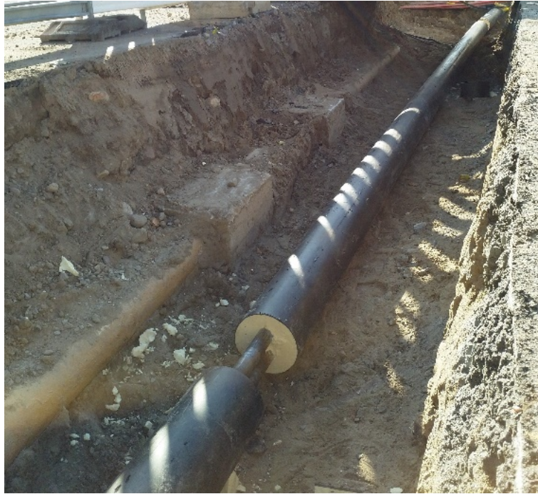
KUVA 4. Liittymän saneerauksessa korvataan vanha Mpul-johto kiinnivaahdotetulla elementtijohdolla. (Heikkinen 2019-09-25).
