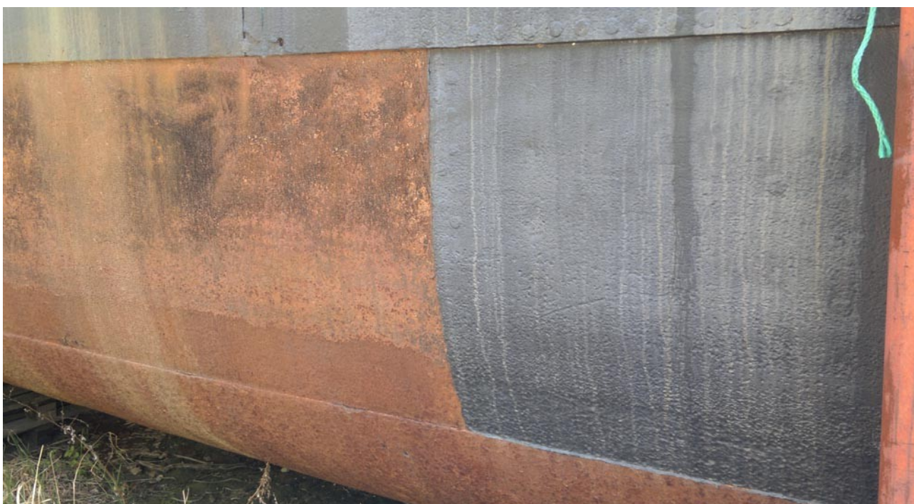
Kuva 18. Säilytettävä levy on maalattu, ja vaihdettavat ovat maalaamattomia
