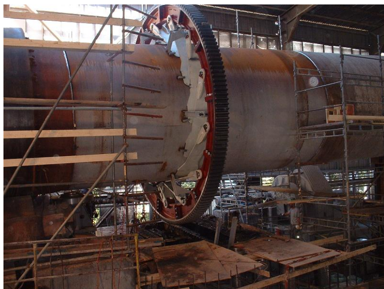
Kuva 13. Asennustyökalut ja jousilevyjen lukitukset hitsattuna paikalleen (2).
