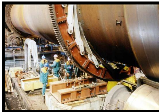
Kuva 10. Jousikiinnitteinen hammaskehäkäyttö (2).
