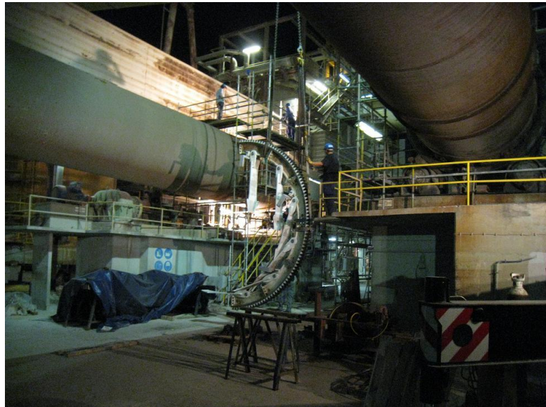
Kuva 12. Segmenttikehän puolikas valmiina paikalleen nostoa varten (2).
