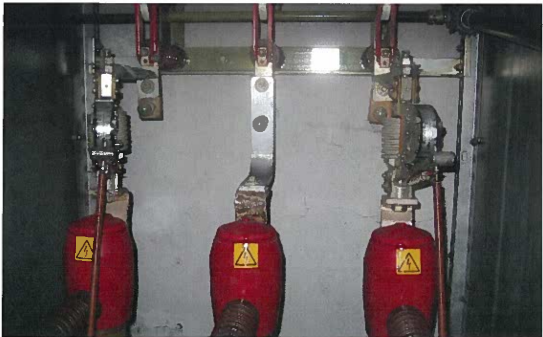
Kuva 18. Vähäöljykatkaisija ja sen suojarleet
