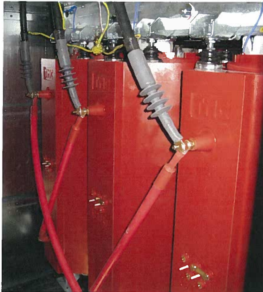
Kuva 20. Muuntajan väliottokytkimet
