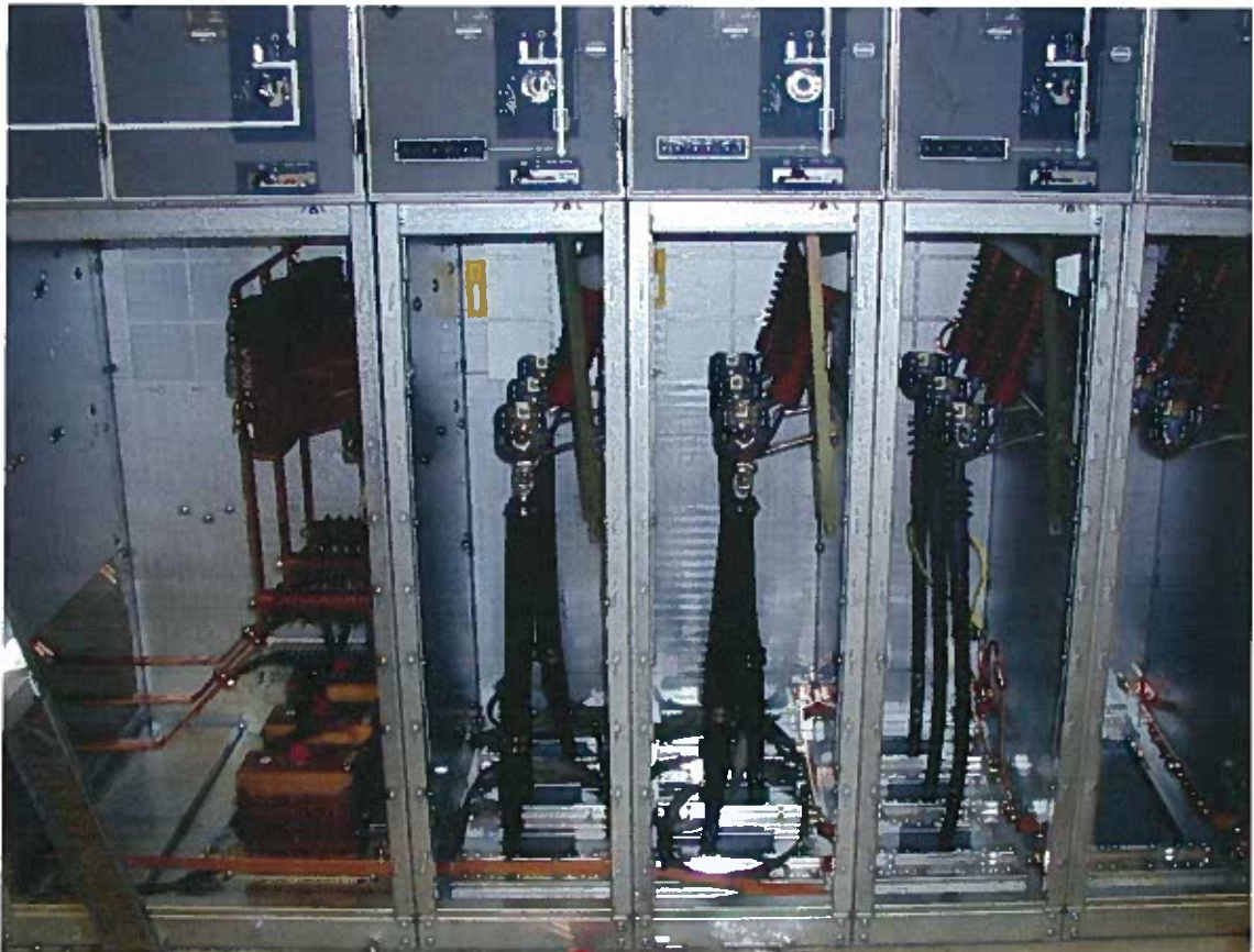
Kuva 12. Keskijännitekojeisto kennot avonaisina
