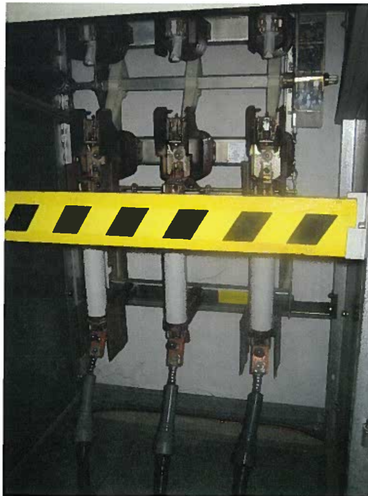
Kuva 13. Varokekuormanerotin avokojeistossa
