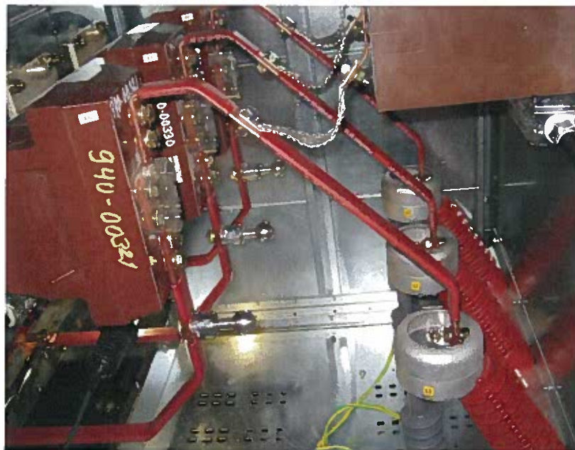
Kuva 16. Keskijännitekojeiston mittauskenno
