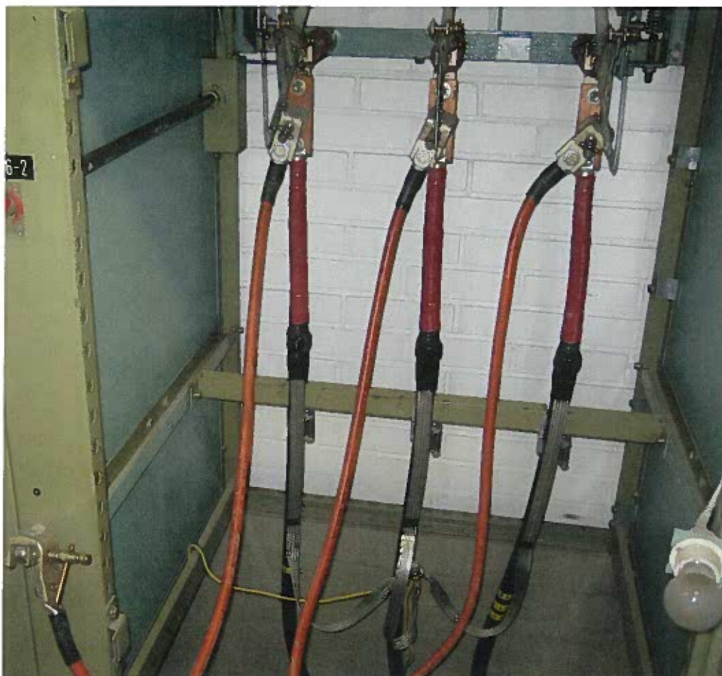
Kuva 8. Siirrettävät työmaadoitusvälineet asennettuna paikoilleen.
