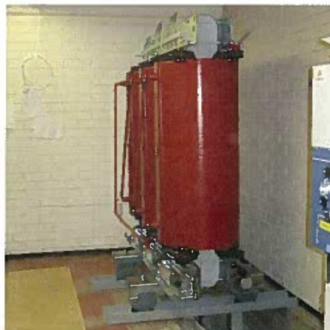
Kuva 19. Uusi muuntaja on kuljetettu paikoilleen asentamista varten
