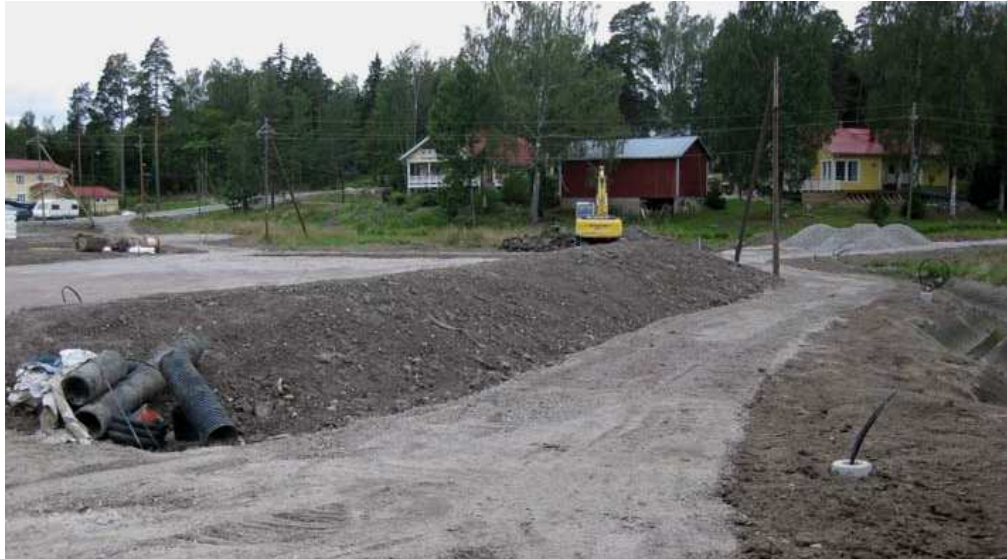
KUVA 15. Pelikentän suojavalli rakennusvaiheessa syksyllä 2010.
