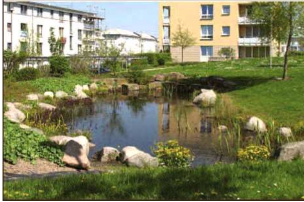
KUVA 12. Rakennettu viivytyksalammikko. (Hyöty 2007.)
