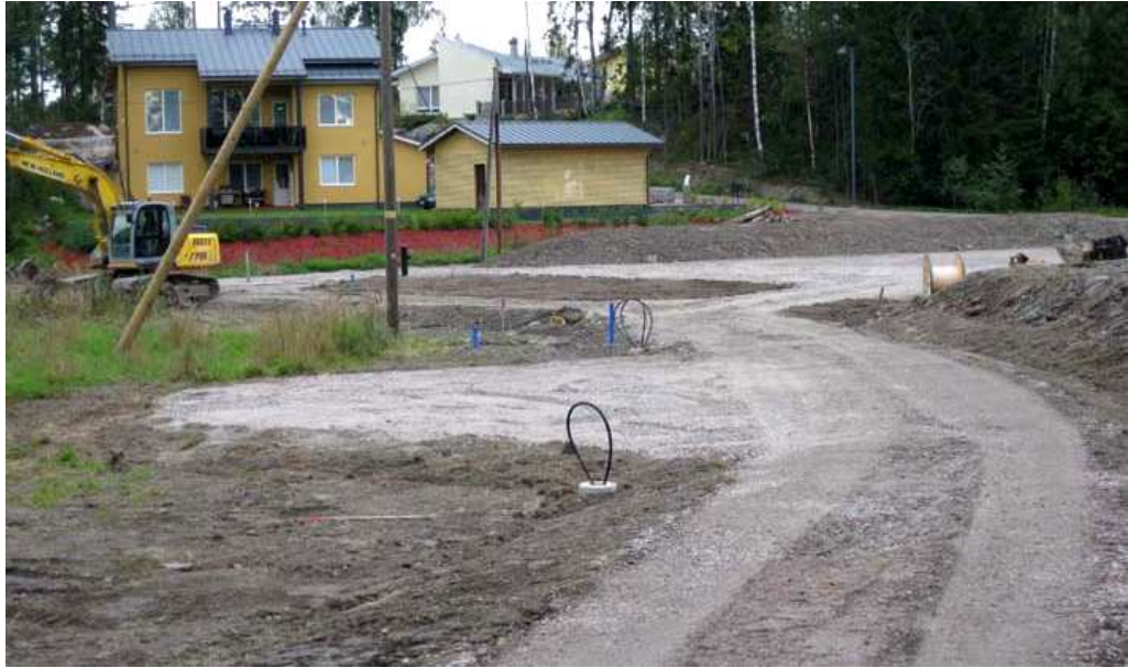
KUVA 13. Mustarastaantien viereinen leikkialue rakennusvaiheessa syksyllä 2010. (Inventointikuvat 2010.)
