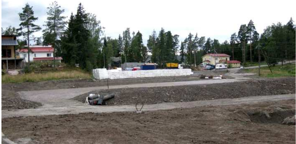
KUVA 14. Pelikenttä rakennusvaiheessa kesällä 2010.
