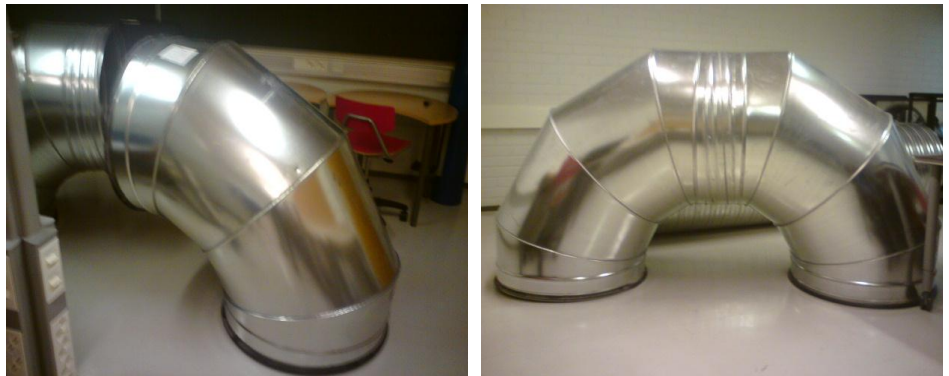
Kuva 27. Putken mutkat ja niiden liitos.
