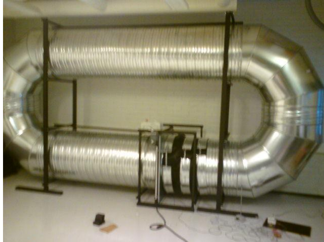
Kuva 30. Putkisto valmiina testaamista varten.
