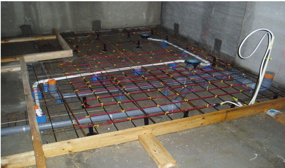
Kuva 10. B16 kylpyhuoneen lattian esivalmistelut valmiina
