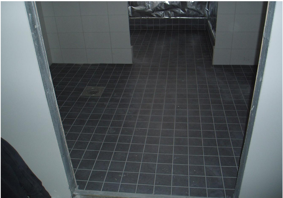
ASUNTO B16 VALMIIKSI LAATOITETTU KYLPYHUONE
