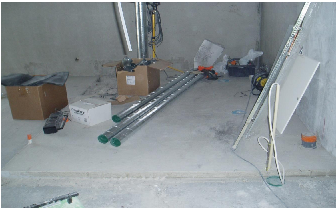
Kuva 11. Asunto B16 kylpyhuoneen kaatolattia valettu
