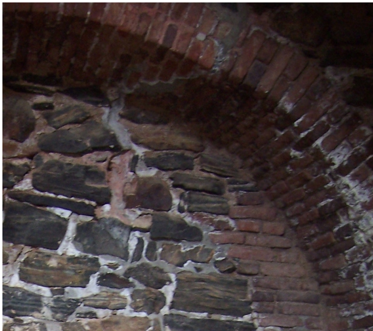
Kuva 2. Olavinlinnan seinä- ja holvimuurausta 1500-luvulta. [3.]
