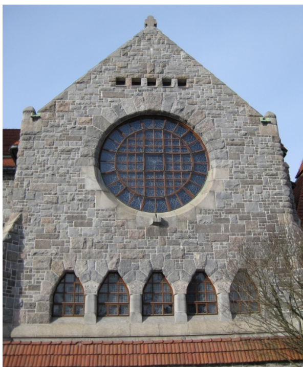
Kuva 3. Tampereen tuomiokirkon, valmistunut 1907, julkisivu on rubble-muurattua graniittia.
