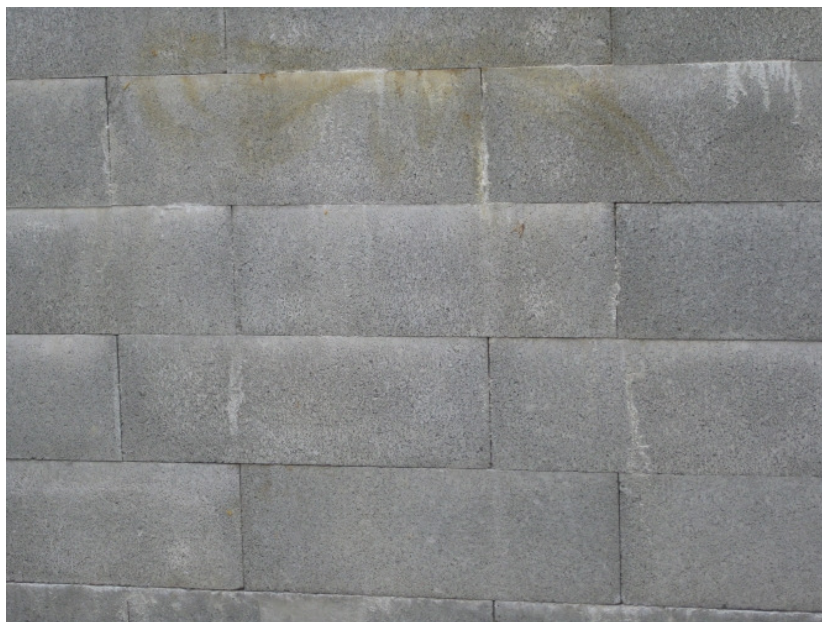
Kuva 9. Valuharkkoilla muurattu seinä
