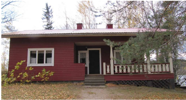
Kuvio 12. Matorannan huvilan julkisivu sisääntulopihan puolelta.
