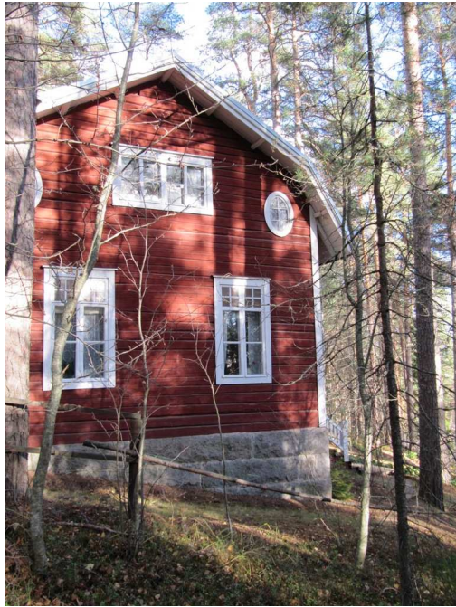
Kuvio 11. Honkaharjun päärakennuksen länsipääty.
