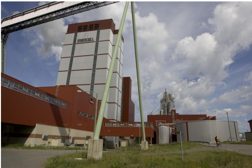
Kuva 8. Soodakattila (Soodakattilayhdistys www-sivut 2019)
