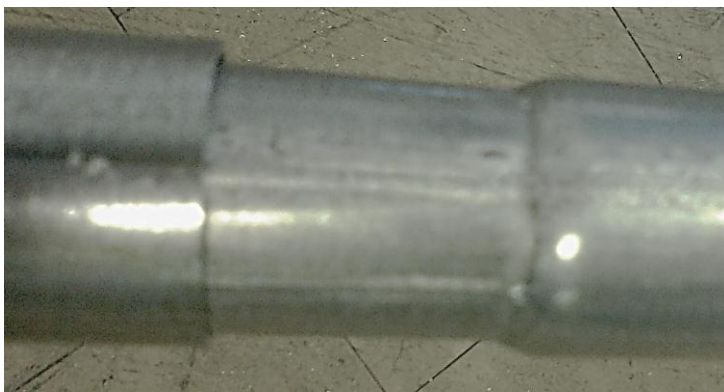
KUVA 2. Putkien liitos (Kuva: Lauri Pelanteri 2011)
