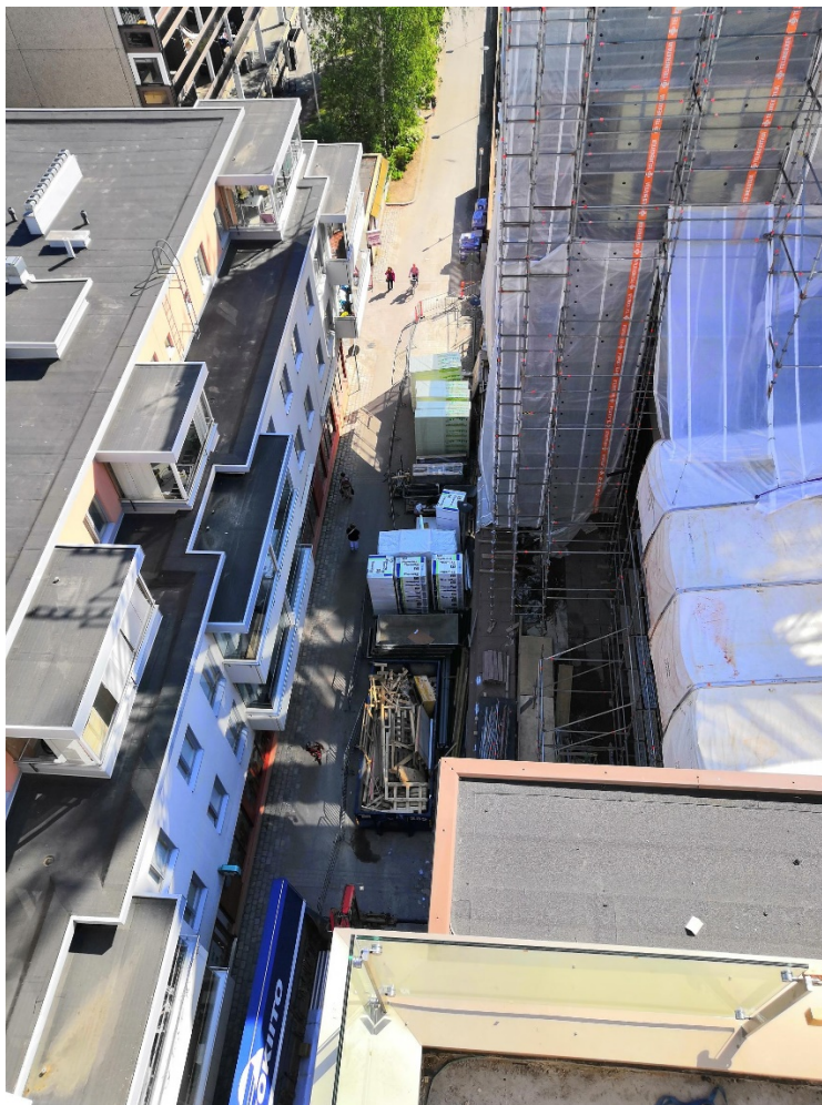
KUVA 15. Työmaan varastointialue kaupungin vuokra-alueella. (Kuva Tuomas Rahunen)
