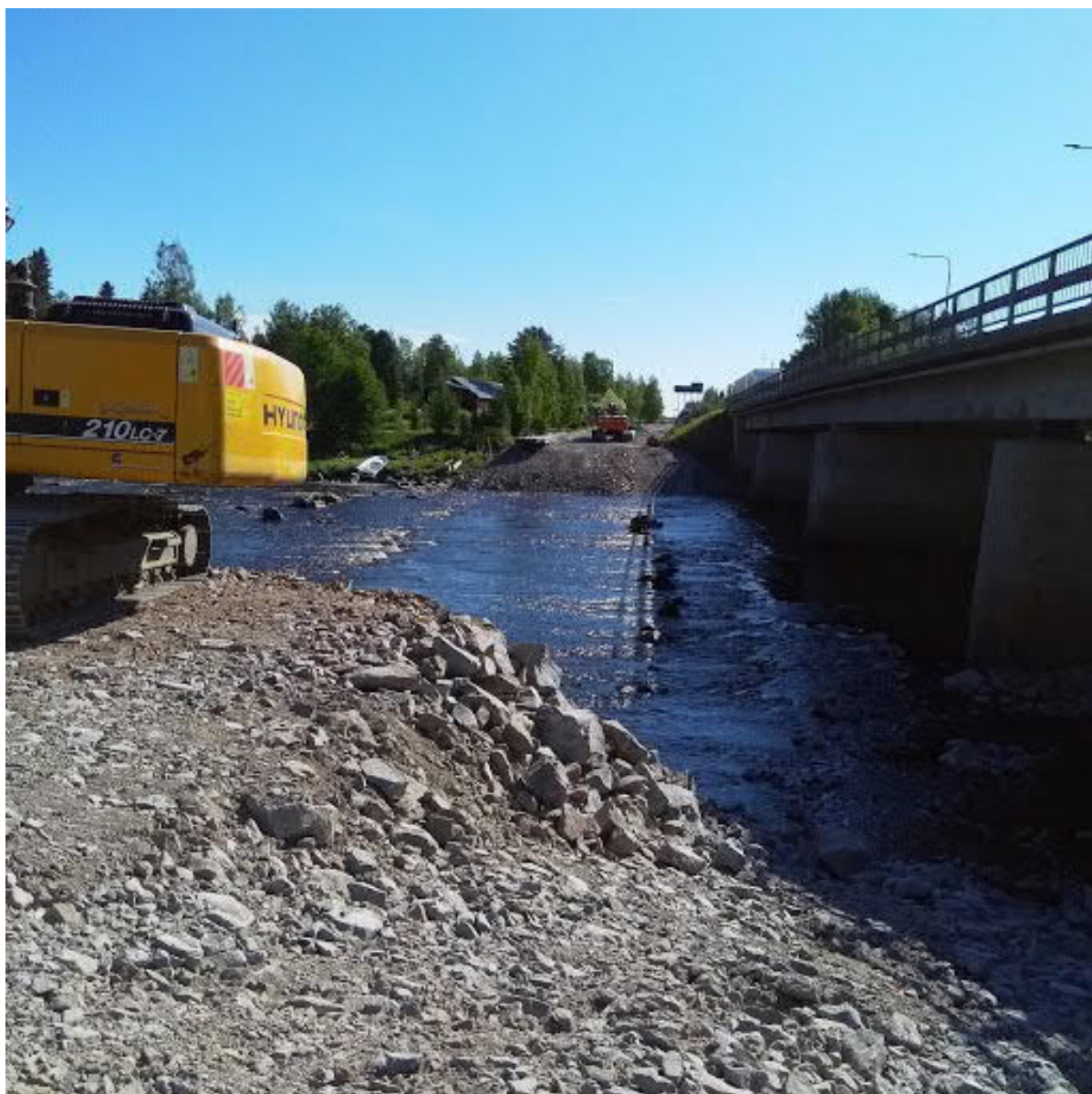
Kuva 4: Paalutustyön lähtökohdat (Hakanen, 2018)
