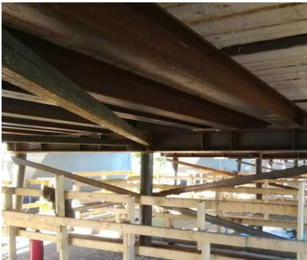
Kuva 11: Uumavahvikkeet ja tuuliseit niskapalkissa (Hakanen, 2018)
