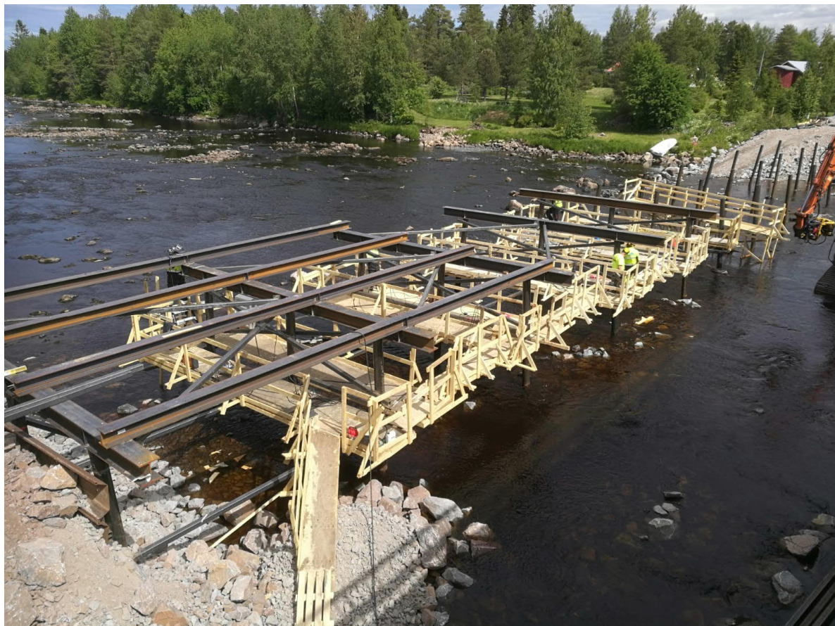
Kuva 25: Varasillan työtelineet (Hakanen, 2018)
