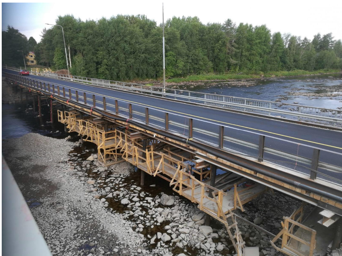
Kuva 22: Valmis paikallaan tehty varasilta (Hakanen, 2018)
