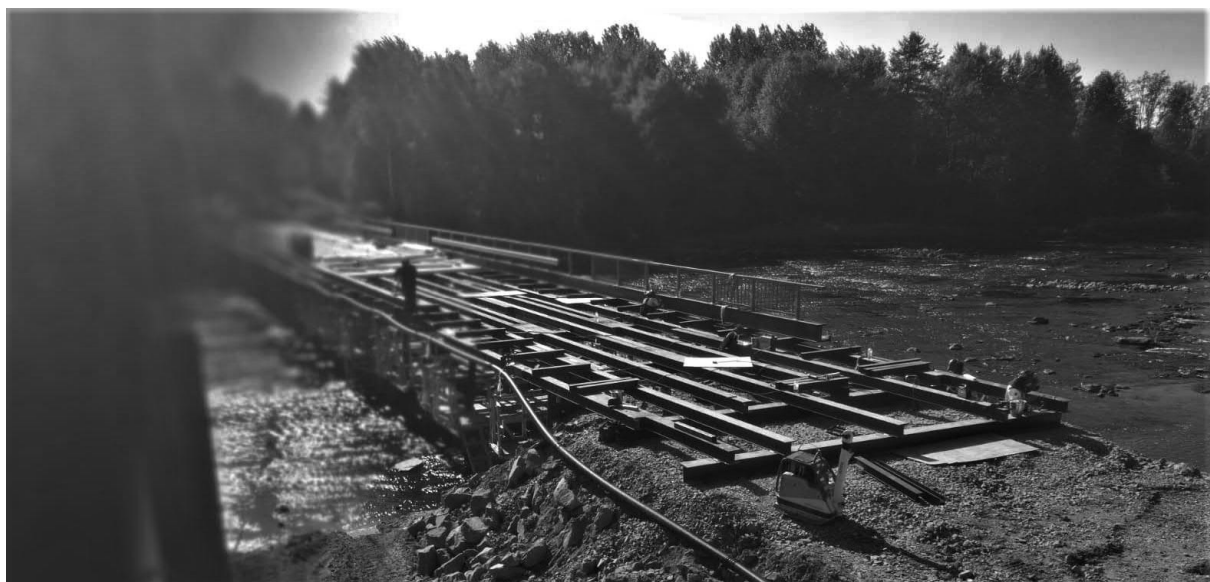
Kuva 14: Alajuoksun puoleinen HE450B – reunapalkki, jonka päällä kaiteet (Hakanen, 2018)
