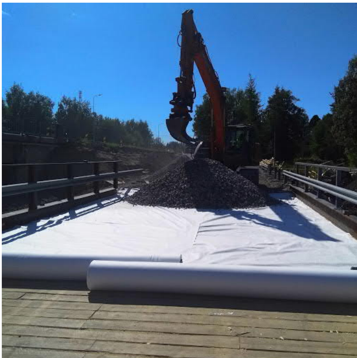
Kuva 20: Rakennekerroksen levitys (Hakanen, 2018)
