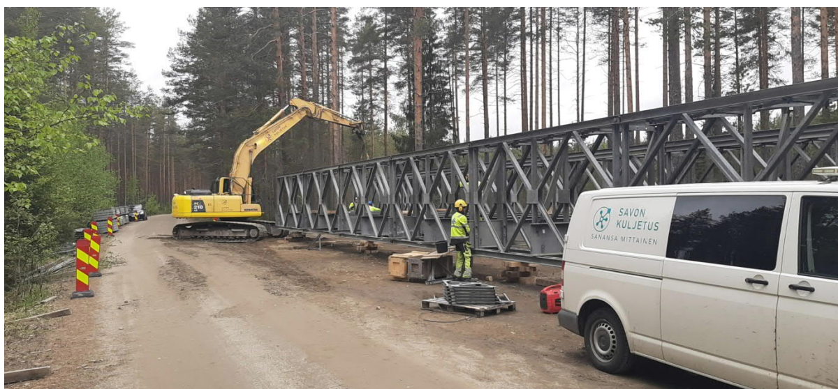
Kuva 27: Kalustosillan rakentaminen (Savon Kuljetus Oy, 2019)
