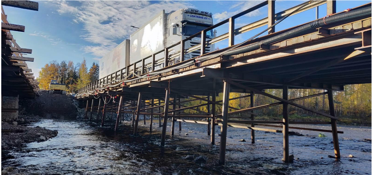
Kuva 23: Varasilta alhaaltapäin (Hakanen, 2018)
