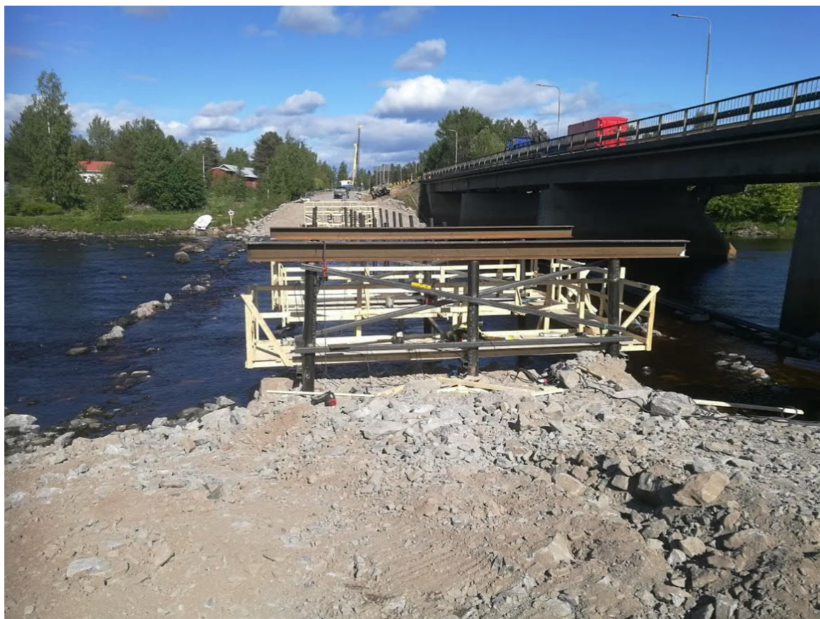
Kuva 7: Niskapalkki ja reivaustyö (Hakanen, 2018)
