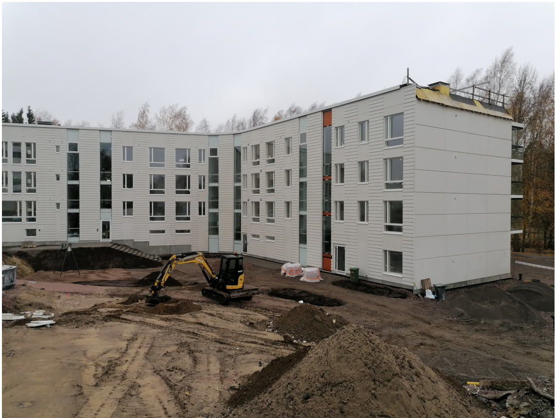
Kuva 1. Pallas Rakennus Etelä-Suomi Oy:n As. Oy Helsingin Vuosaaren Sävel -työmaa kuvattuna 25.10.2019.
