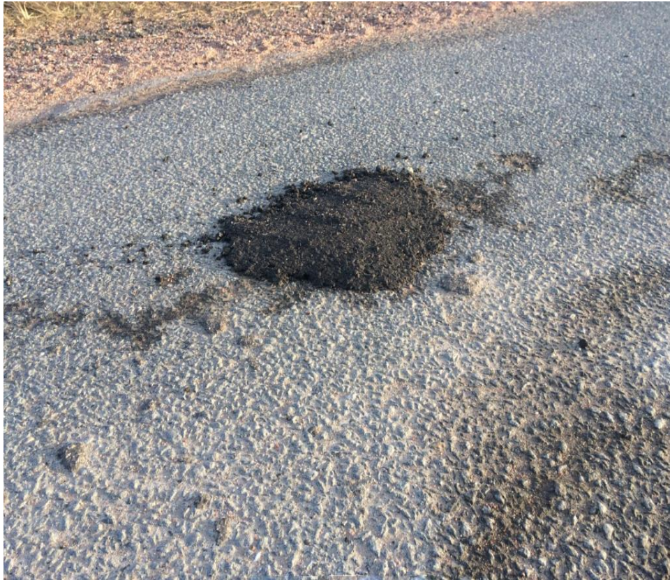
Kuva 8. Juuri tehty PAB-paikkaus yhdystiellä.
