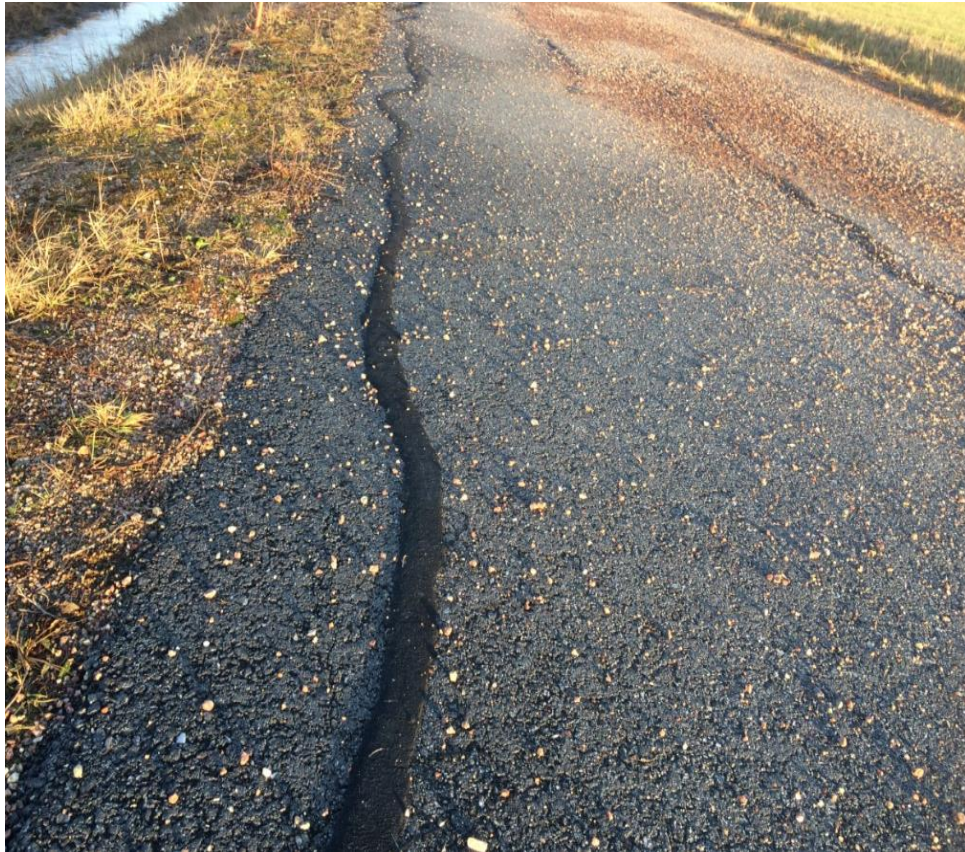
Kuva 6. Jalankulun ja pyöräilyn väylien kiinnijuotettuja halkeamia.
