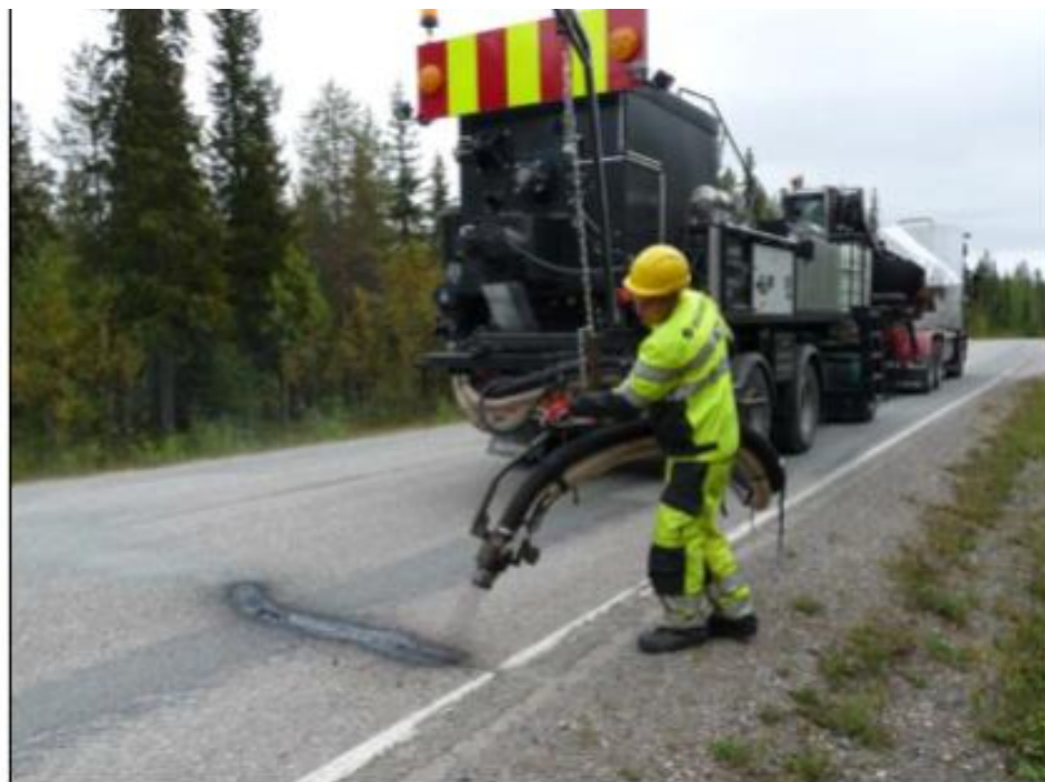
Kuva 11. Sirotepuhalluspaikkaus (Väylävirasto, 2009).
