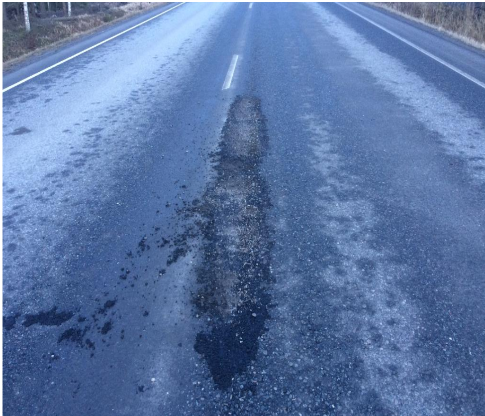
Kuva 7 Juuri tehty KT-valuasfalttipaikka valtatie 11 tammikuussa 2020.
