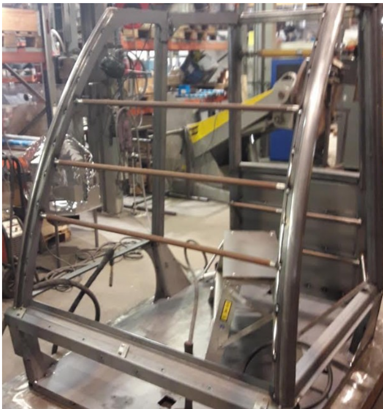
Kuva 4. kolme terästankoa käytössä hytin rungon silloituksessa. (Anssi Korpunen 2019)
