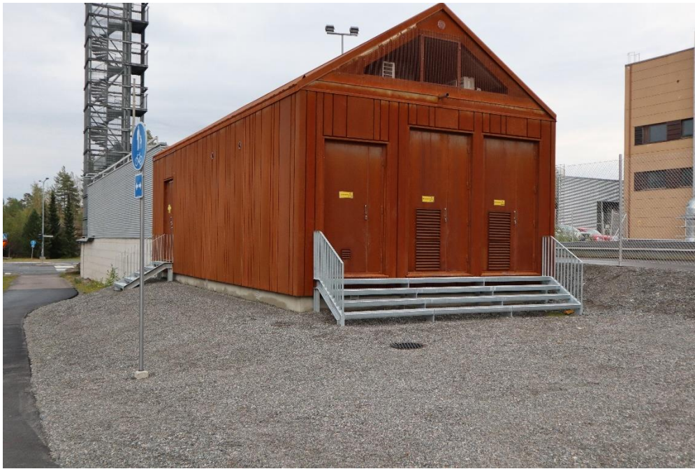
Kuva 14. Sähkönsyöttöasema Hervannan paloaseman vieressä.
