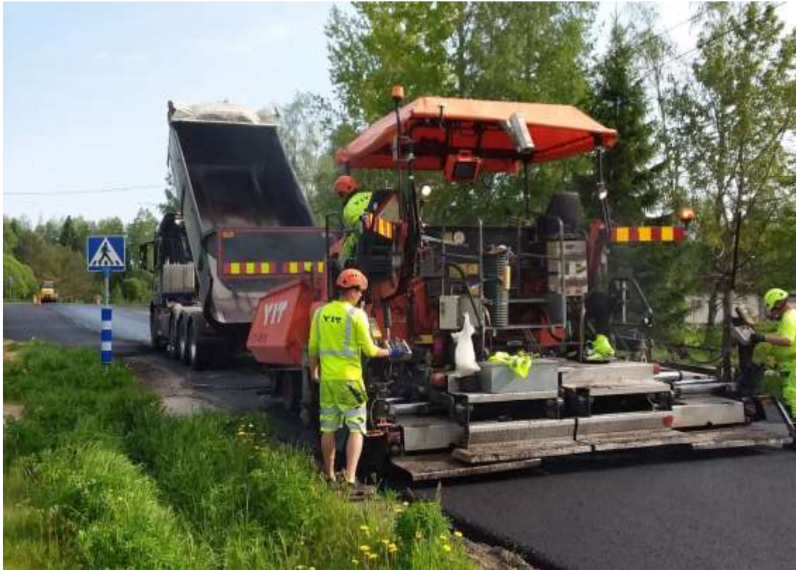
KUVA 3. Lämpökamerajärjestelmä käytössä ajoradan päällystämässä.
