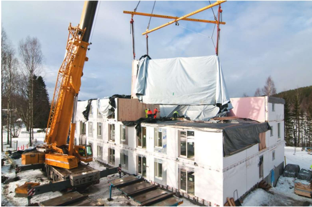
Kuva 15. Saarijärven omatoimi, moduulin asennus (JVR- rakenne 2015).
