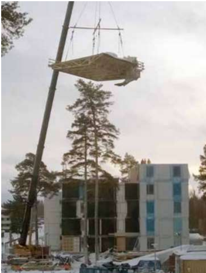
Kuva 20. Sääsuoja elementin asennus paikalleen (KKES 2017, 50).
