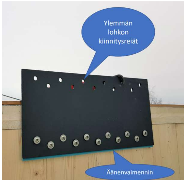
Kuva 16. Elementin kiinnitys. (Jwood, asennus, 51).
