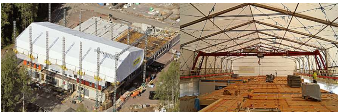
Kuva 18. Työn mukana nouseva sääsuoja siltanosturilla (Ramirent, palvelut).
