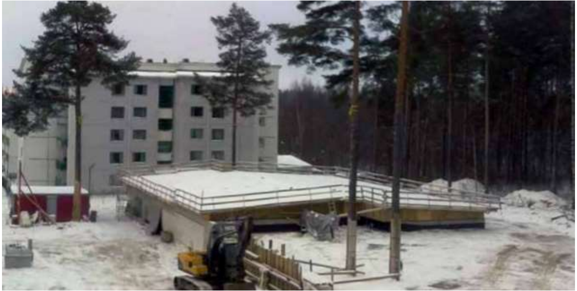
Kuva 19. Sääsuoja elementti (KKES 2017, 46).
