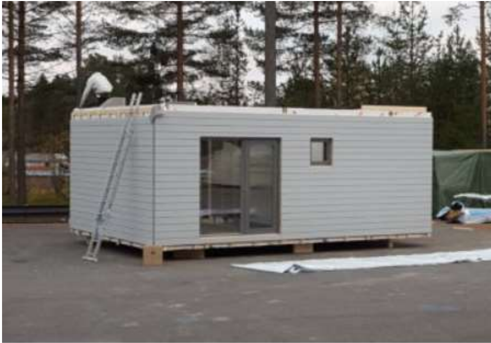
Kuva 10. Kuljetusvalmis moduuli ilman suojausta (Elementti Sampo, moduulit).
