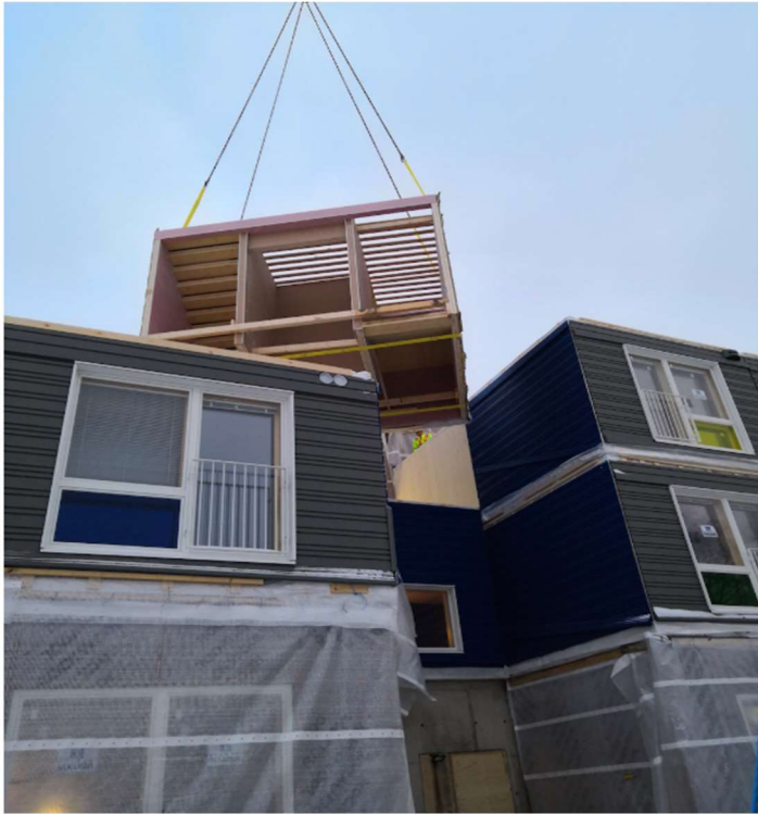
Kuva 9. Moduuleitten asennus (Elementti Sampo).
