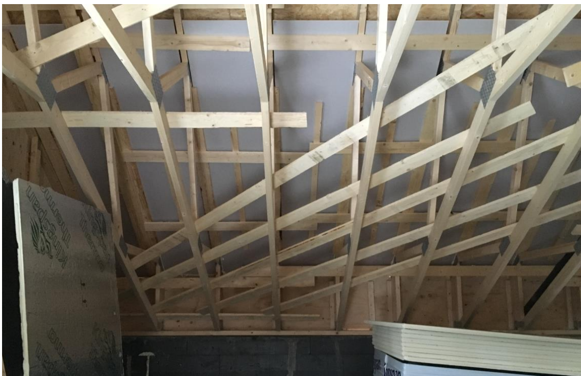
KUVA 3. Ristikoiden tuentaa ja tuulenohjaimet
