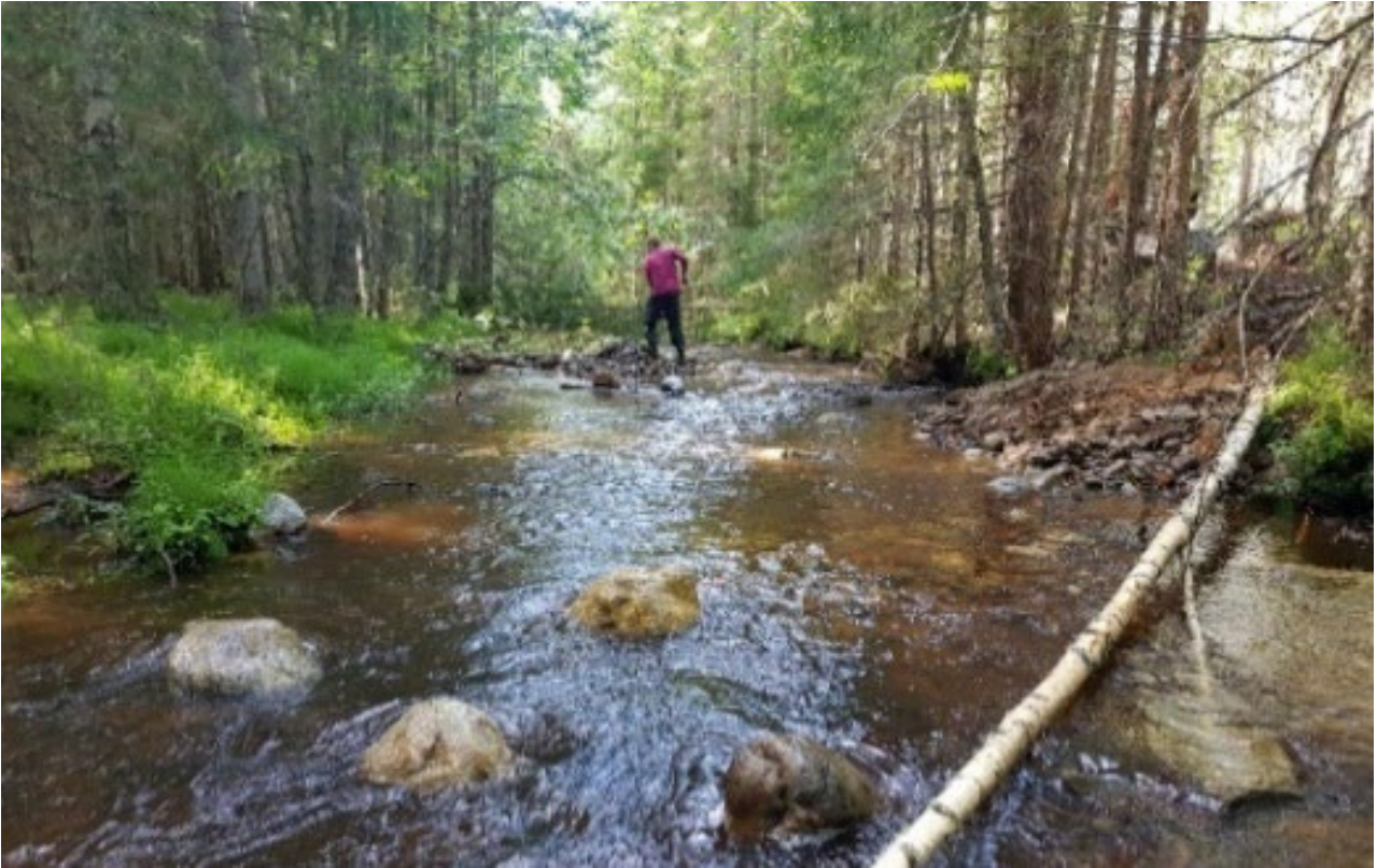
Kuva 51. Konetyön täydentämistä ja hienosäätöä henkilötyönä Jukajoen yläjuoksun koskialueella kesällä 2019. Kuva: Janne Raassina.
