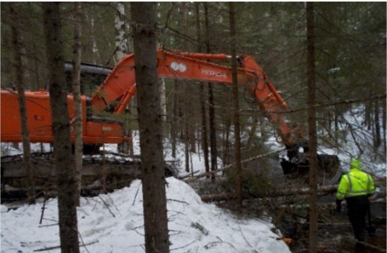
Kuva 50. Jukajoen yläjuoksun koskialueen kalataloudellinen kunnostusta 28.03.2019. Joki uomassa kaivinkoneen työtä ohjailee vesistökunnostusyrittäjä Janne Raassina.
