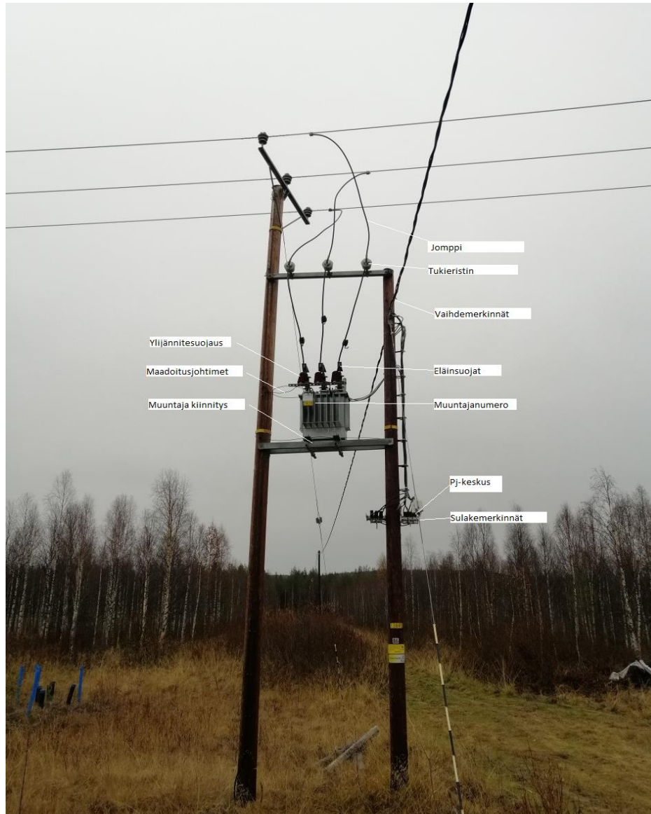
Kuva 4. Tarkistettavat kohteet pylväsmuuntamosta
