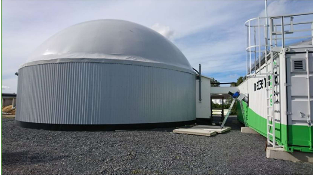
Kuva 2. Maatilakokoluokan märkämädättämö, jossa syötteinä voi olla lietelanta, kuivalanta ja erilaiset rehujakeet (Demeca Oy, [viitattu 18.11.2019]).
