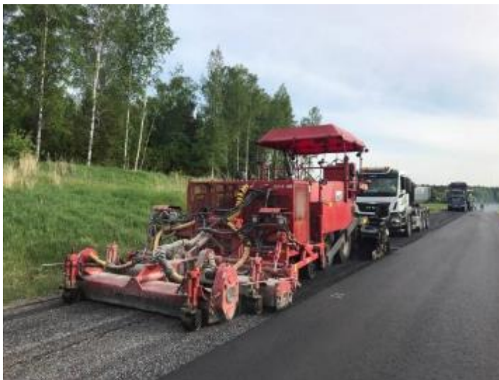
Kuva 10. MPKJ töissä käytettävä kuumajyrstin
