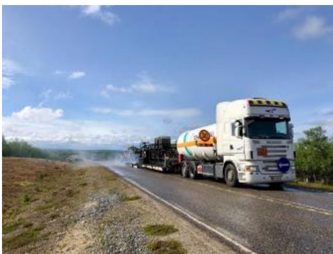
Kuva 6. UREM-kohde nestekaasulämmittiminen ja asfalttikoneineen (Ncc Aja Hiljaa)
