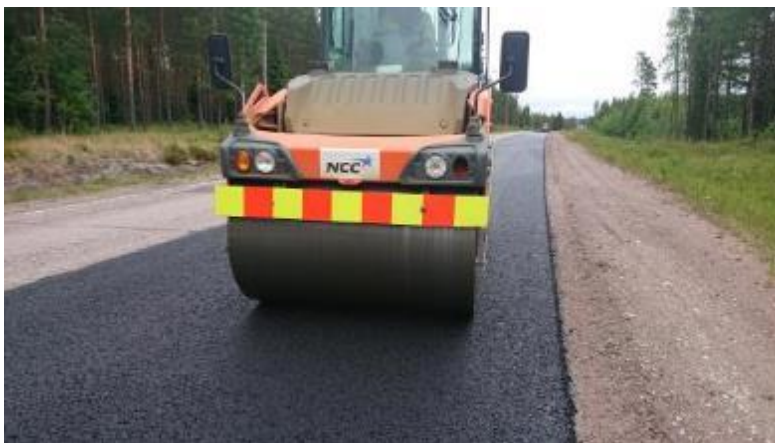
Kuva 8. Asfalttipinnan tiivistämisessä käytettävä tiejyrä
