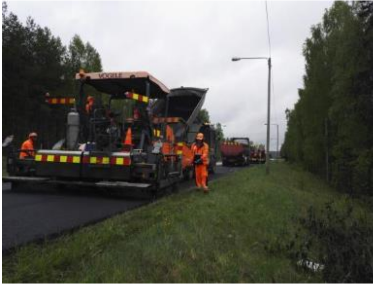
Kuva 7. Uusiokohteissa käytettävä asfalttikone MP, MPKJ (ncc.fi)
