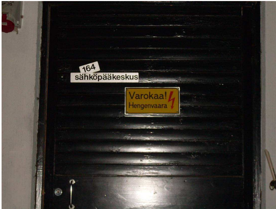
Kuva1. PK huoneen ovi.
