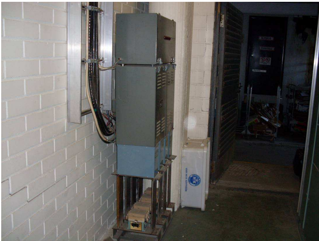
Kuva 3. Pääkeskuksen kompensointiparistot
