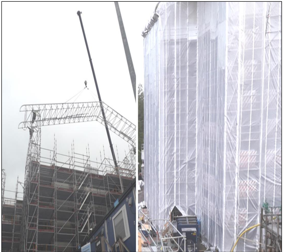
Kuva 12. Vasemmalla puolella sääsuojan asennus käynnissä ja oikealla sääsuoja valmiina.
