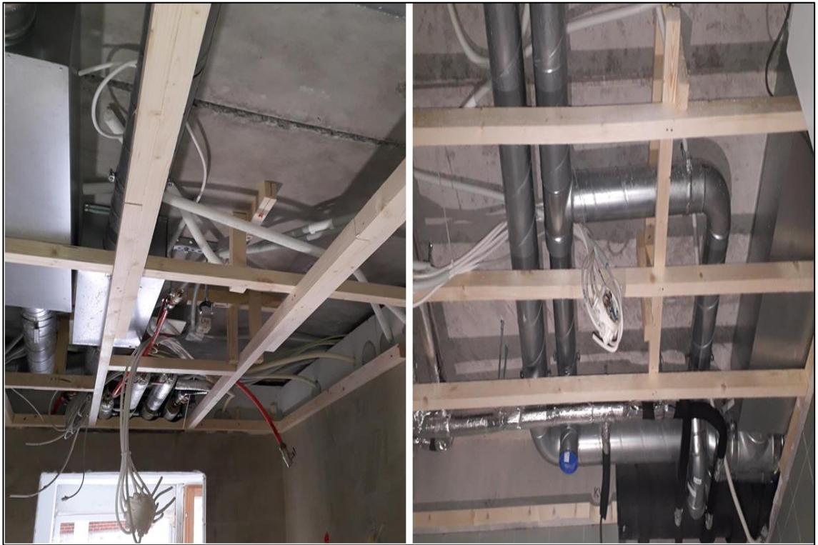
Kuva 8. Esimerkki alaslasketun katon runkorakenteesta ja siellä näkyvästä talotekniikasta.
