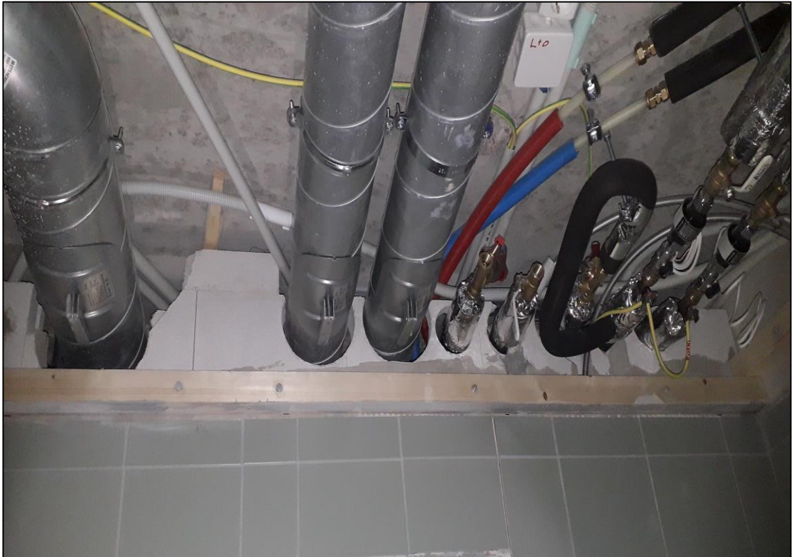
Kuva 18. Seinän läpi tulevia IV-, lämpö- ja vesiputkia, jotka asennettu muuraustyön jälkeen.
