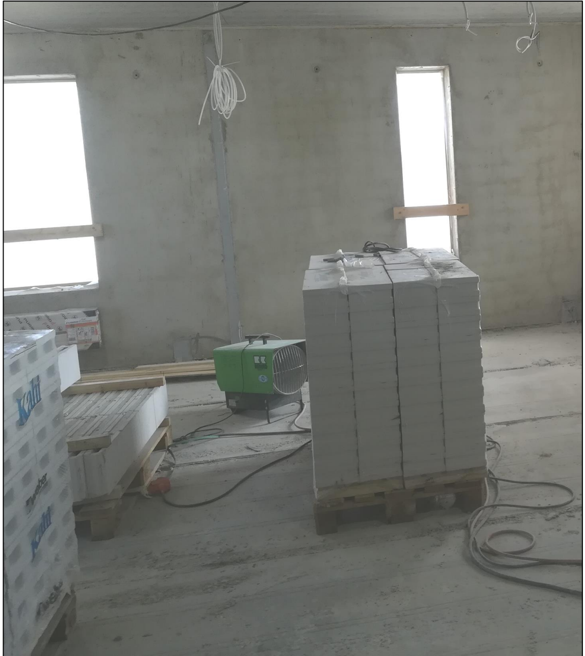
Kuva 15. Runkovaiheessa täsmänostona tulevat Kahi väliseinäpöytä ja oven ylityspalkit.
