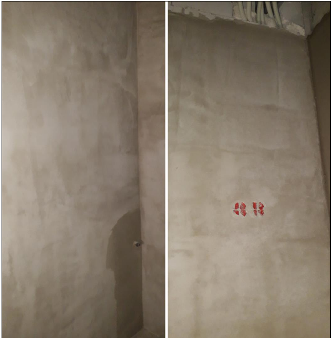
Kuva 20. Seinäpinnat nollatasoituksen jälkeen.
