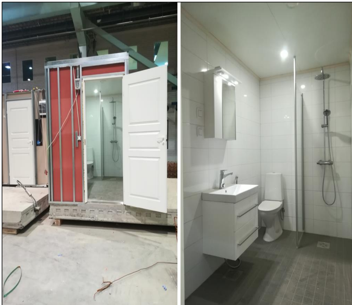
Kuva 43. Lujabetoni Oy:n kehittämä valmis kylpyhuonemoduuli Järvenpään tehtaalla 18.2.2020 kuvattuna. Vasemmalla moduuli ulkopuolelta ja oikealla sisäpuolelta kuvattuna.
