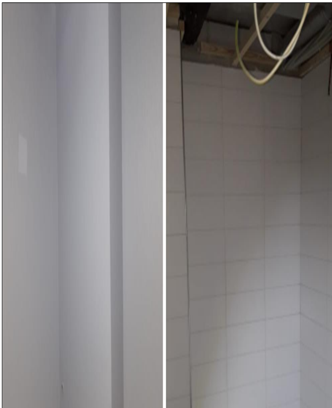
Kuva 24. Vasemmalla puolella seinät vedeneristettynä ja oikealla laatoitettuna.
