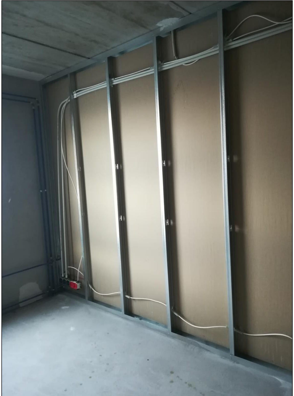
Kuva 27. Levväliseinissä ennen tuplausta näkyviä sähköjohdotuksia ja -rasioita.
