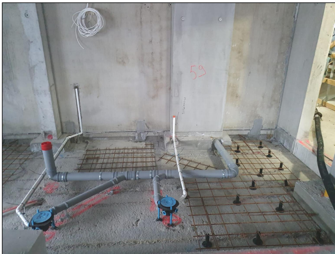
Kuva 14. Viemärien hajotukset tehty kuorilaatan päälle ennen 200 mm paksua betonivalua.
