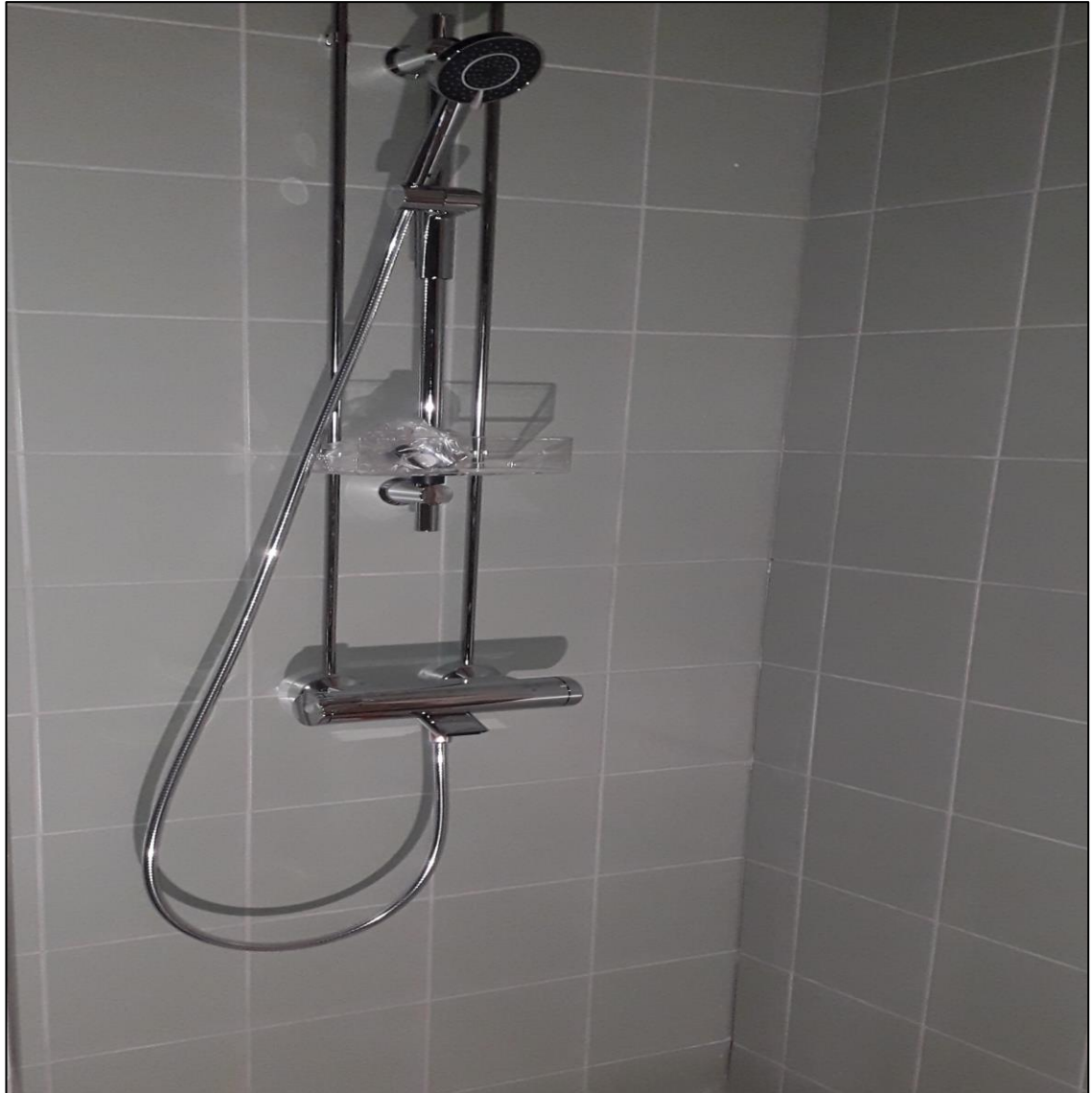
Kuva 6. Suihku on kiinnitetty huoneistojen väliseen betonielementtiseinään ja toisella puolella on muurattu kahiseinä.
