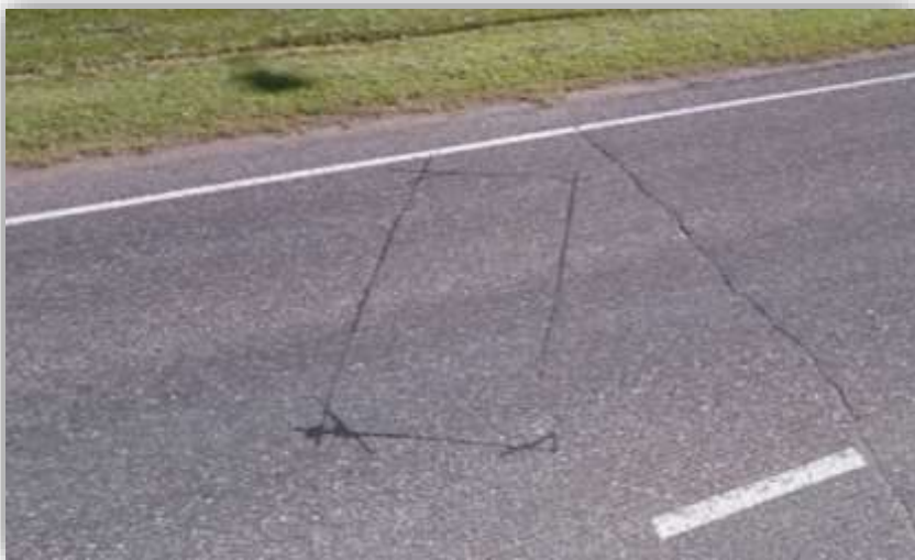
KUVA 2. Sahattuihin uriin asennettu silmukkailmaisoin maastossa (Lintulammen- tie, Oulu. 2011)
