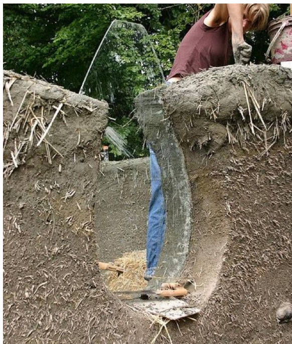
Kuva 27. Sullotun seinän rakentaminen (Pinterest n.d.)
