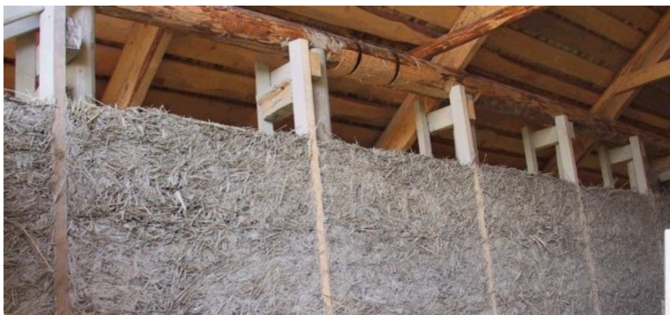
Kuva 15. Valumuotilla toteutettu kevytsaviseinä (Putkilahden kylälehti, 2011)
