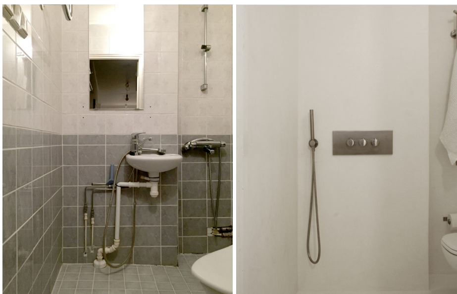
Kuva 40. Kylpyhuoneremontin alkutilanne ja lopputilanne, Helsinki (Natural Building Company, n.d.)
