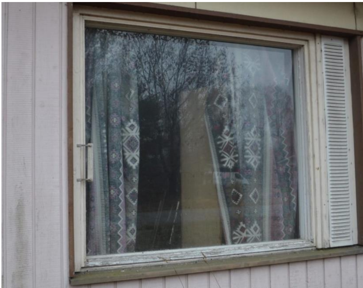
Kuva 8. Alkuperäinen ikkuna (Luukkonen&Leikas 2019-11-12)
