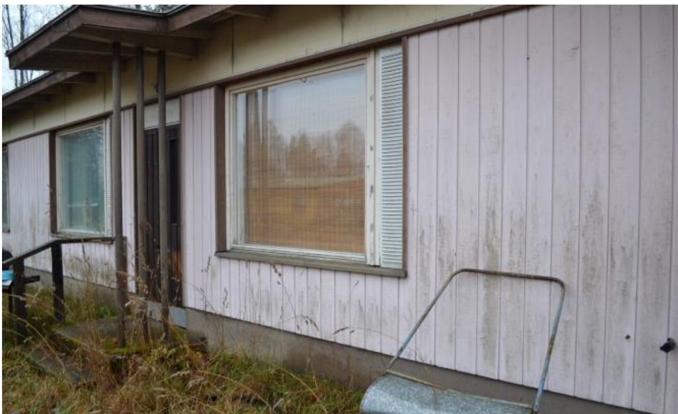
Kuva 7. Ulkoseinän puuverhous (Luukkonen&Leikas 2019-11-12)
