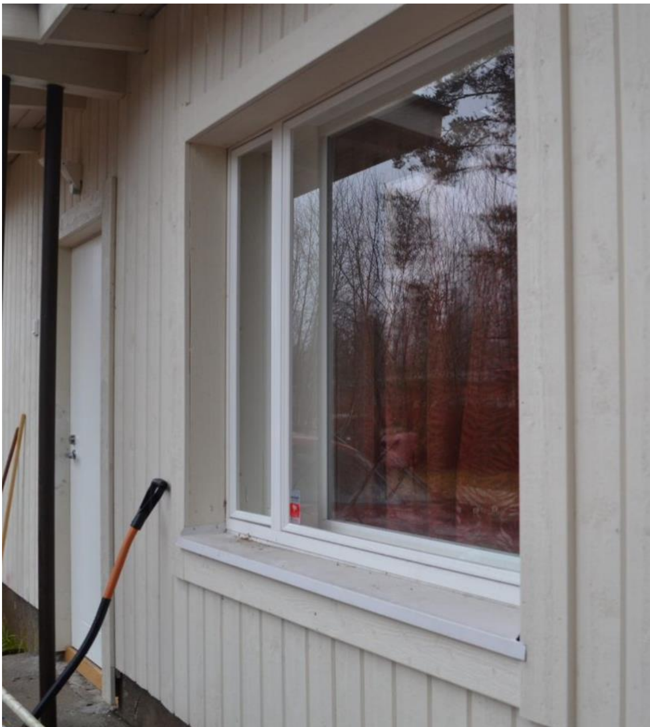
Kuva 9. Vaihdetut ikkuna ja ulko-ovi (Luukkonen&Leikas 2019-11-12)
