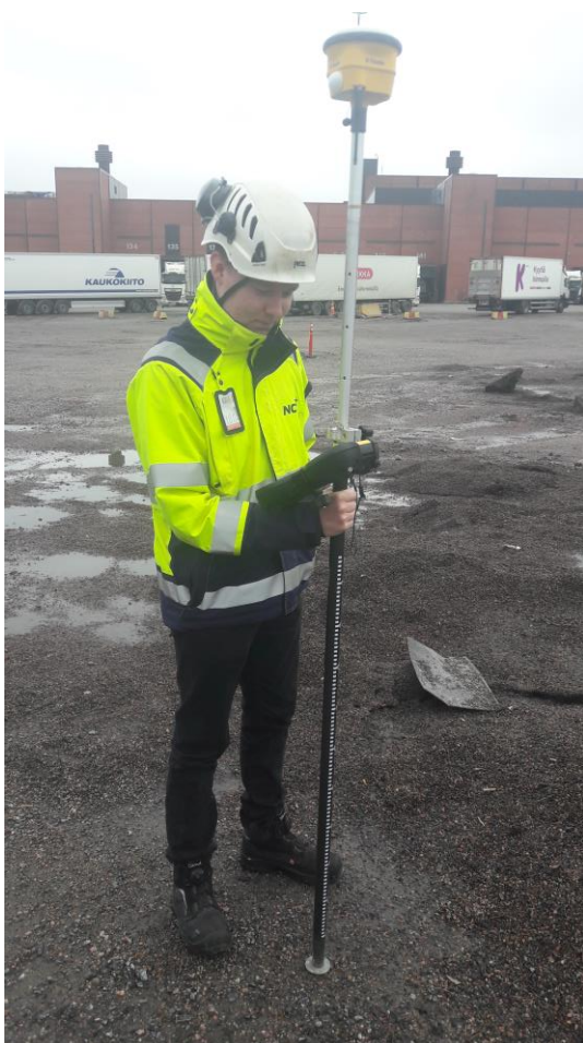
Kuva 8. Raakapohjien koron tarkastelua GPS-mittausta hyödyntäen.
