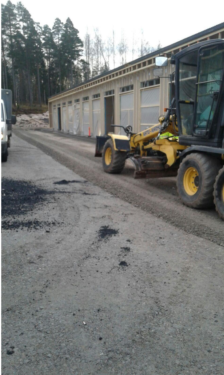
Kuva 2. Pieni tiehöylä profiloi kantavaa kerrosta.
