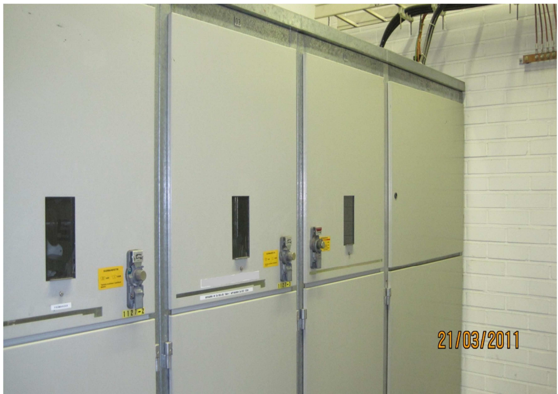
Kuva 2. Keskijännitekojeisto
