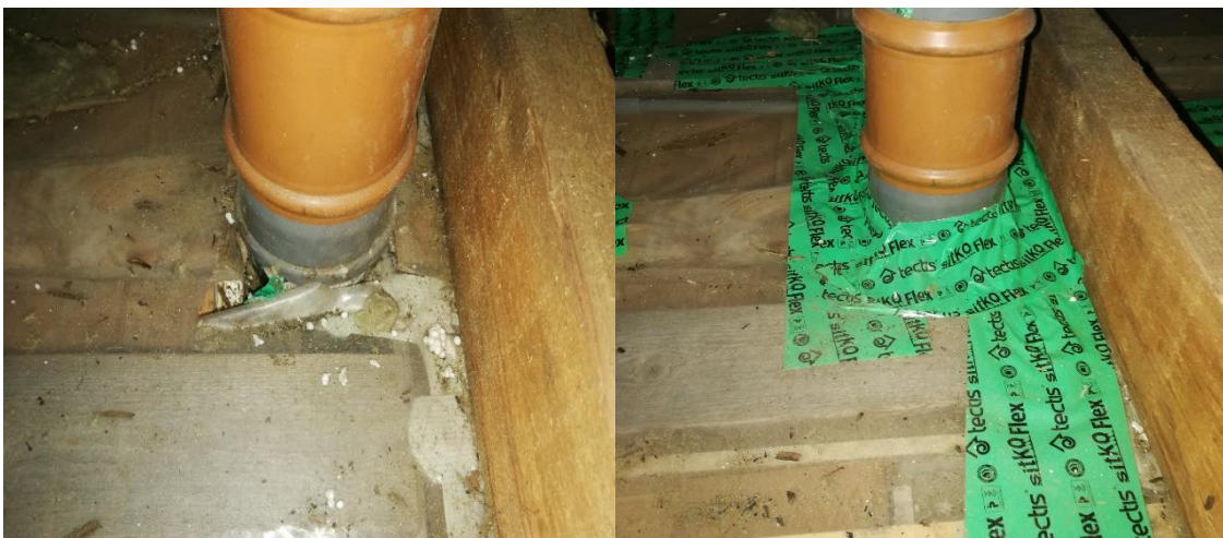
KUVA 24. Viemärintuuletusputken läpivienti
