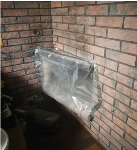
KUVA 13. Takka peitettynä ilmatiiviisti
