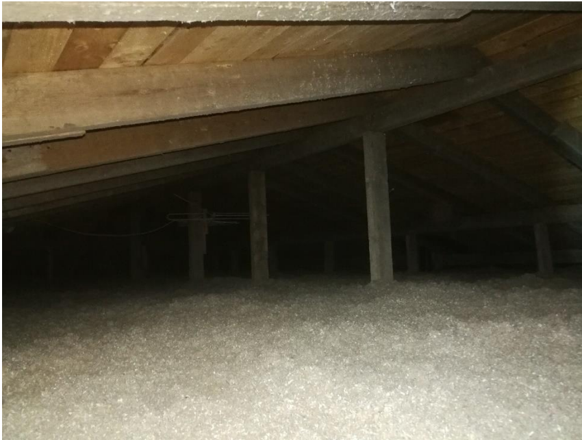
KUVA 27. Yläpohjaan puhallettu Ekovilla-puhallusvilla
