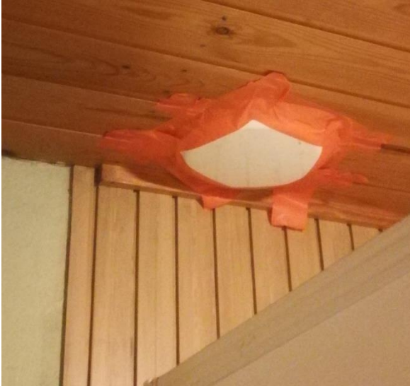
KUVA 12. IV-poisto tukittuna
