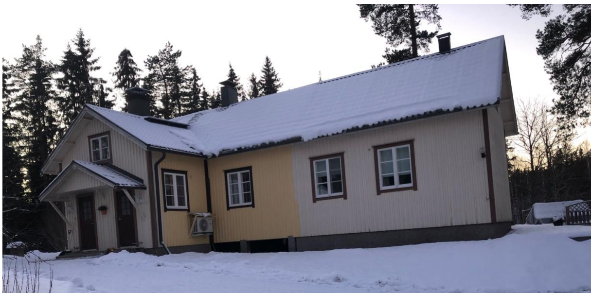
KUVA 1. Työn kohteena ollut omakotitalo
